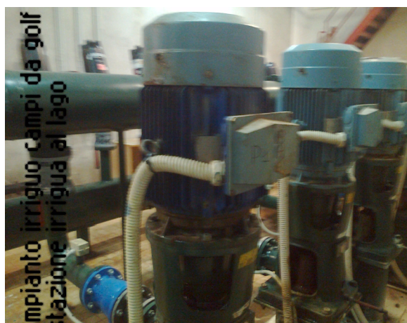
Figure 4.11 e 4.12: inverter con sistema soft start per l'acqua in entrata e per quella in uscita e 3 delle 5 pompe che servono il campo da golf.
