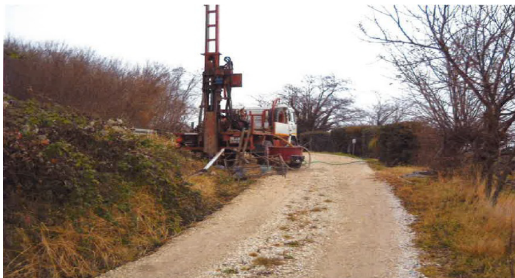
Figura 10: Esecuzione della perforazione a carotaggio continuo.
