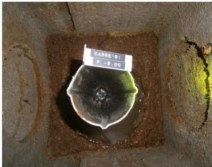
Figura 13: Tubo inclinometrico 1 (Fonte: Zoggia, 2014).
