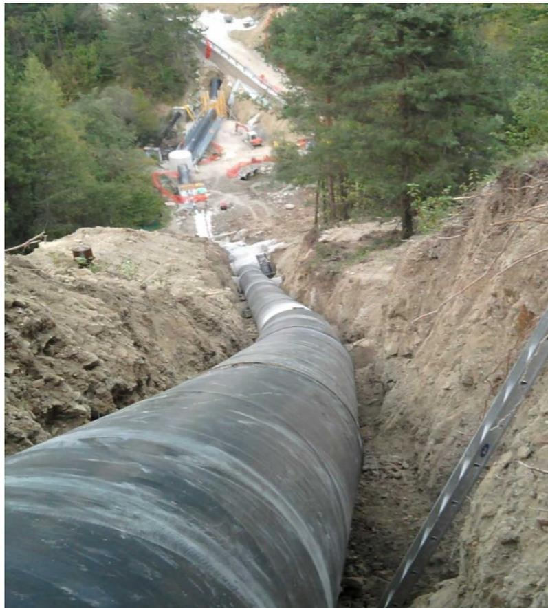
Figura 9: Posa di una condotta di adduzione.
