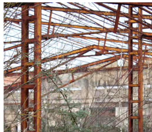
Particolare degli elementi verticali che portavano la copertura della zona più a ovest del deposito
