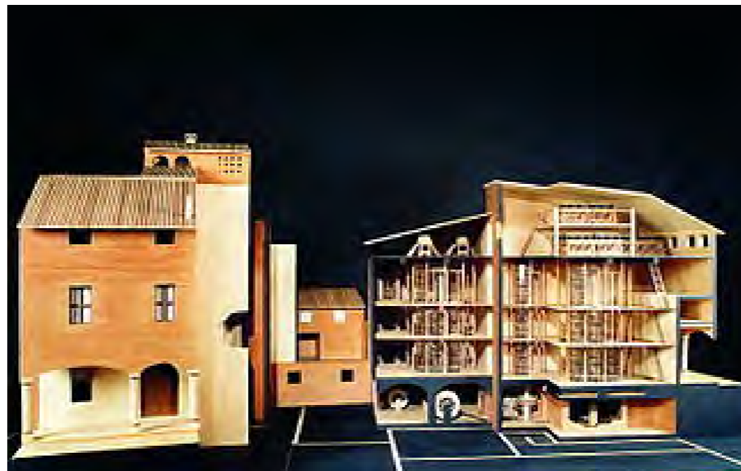
Plastico di un mulino da seta "alla Bolognese"
