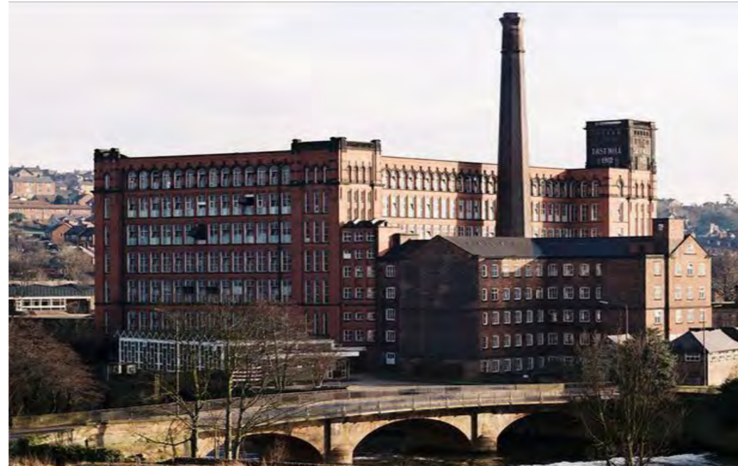
Belper Mill in origine con una struttura a pilastri e travi portanti in legno, riedificato nel 1808 dopo un incendio è la più esemplare applicazione delle nuove tecnologie costruttive (ferro e ghisa) e concezione sull'educazione della manodopera con la prima scuola domenicale costruita nell'atrio e destinata all'educazione dei bambini che durante la settimana lavoravano ai piani inferiori.
