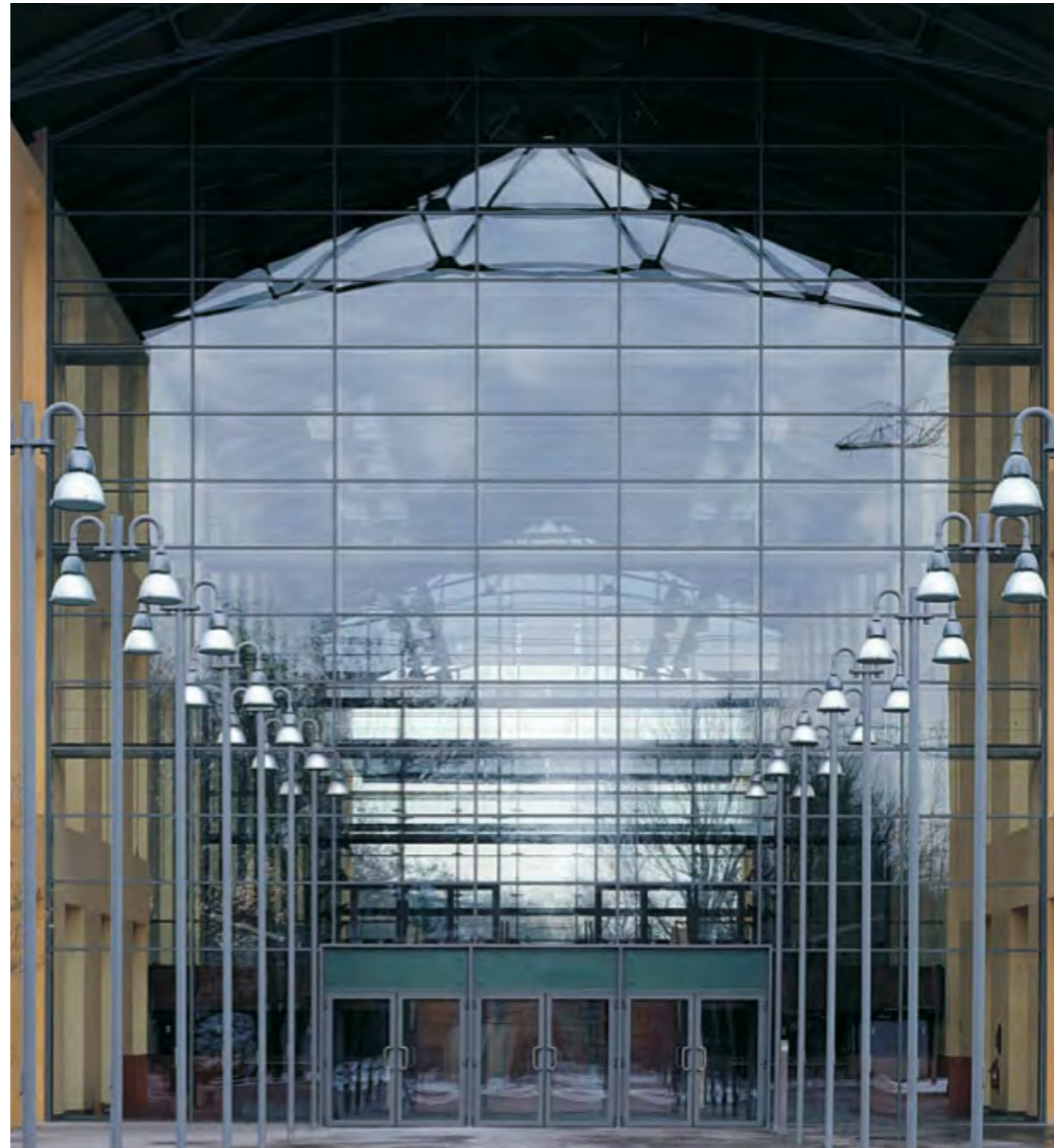
Vista dell'ingresso all'auditorium
