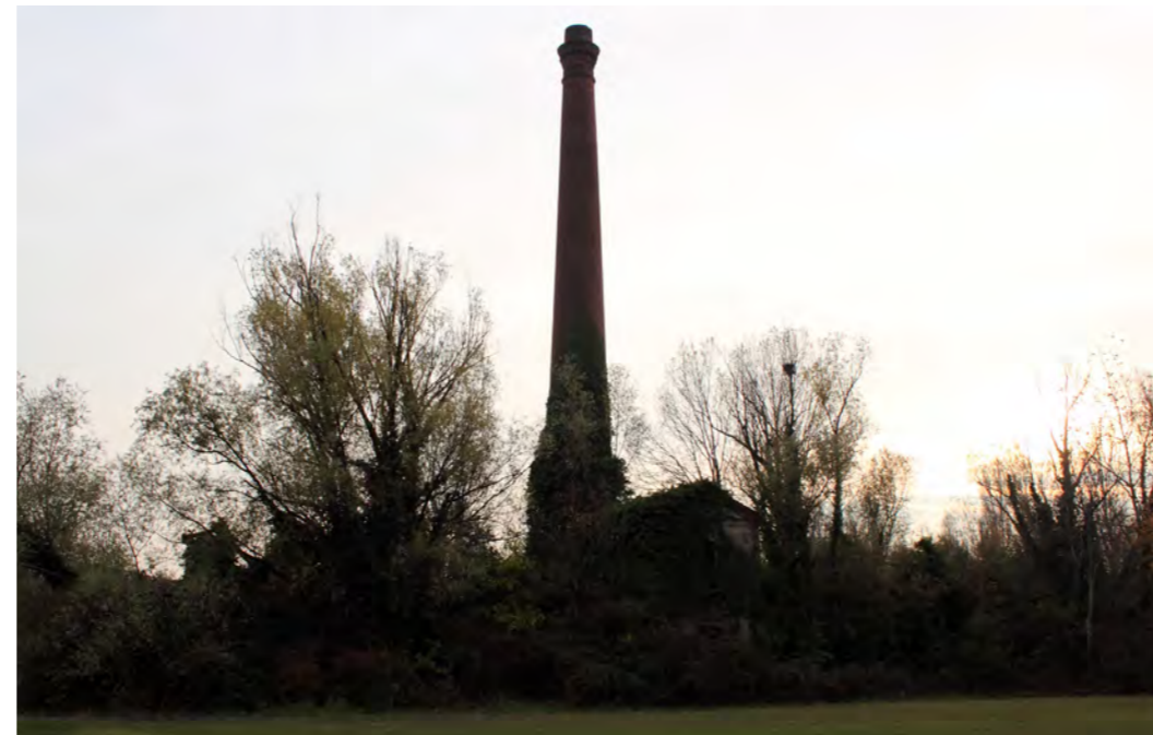
Fotografia che mostra chiaramente quello che resta della fornace e il degrado in cui si trova
