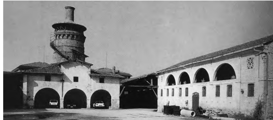
Fornace da calce Finesso a Padova, costruita nel 1897
