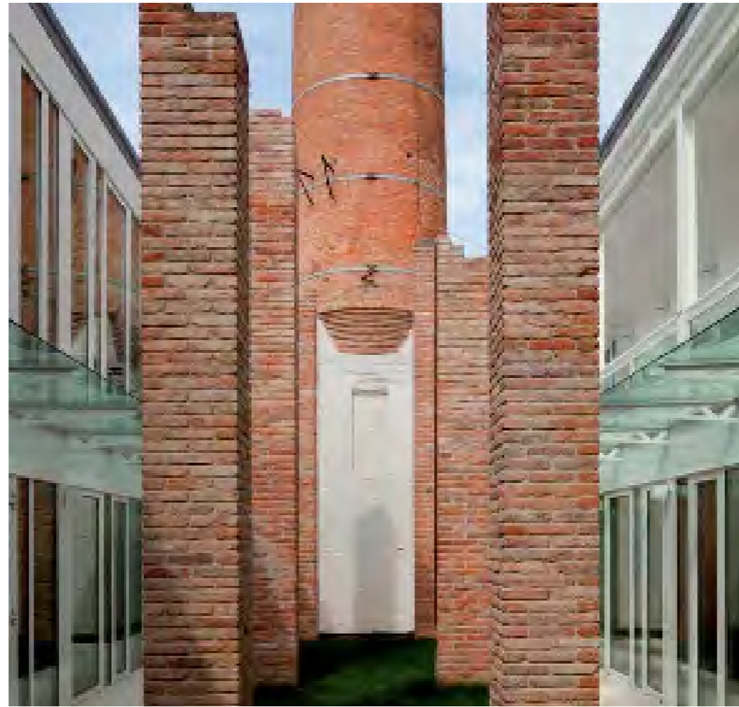
Particolare del cortile interno
