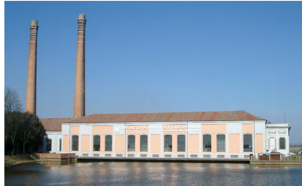
Le due ciminiera "a foderà" dell'impianto Acque Basse di Codigoro
