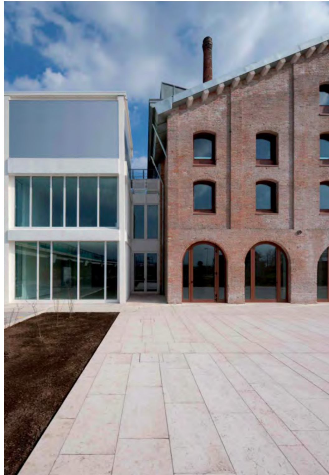
Fornace Morandi dopo gli interventi di restauro
