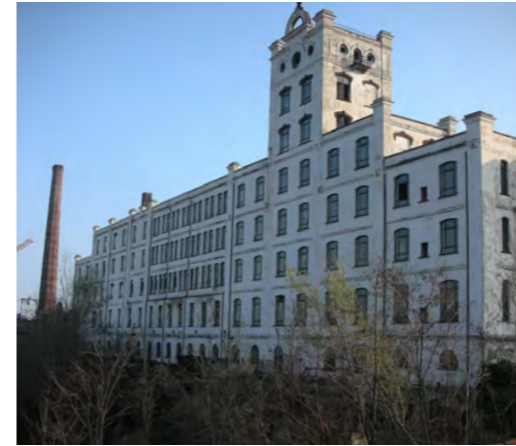
Cottonificio Cuornè di Crespi D'Adda, contenitore in stile lombardesco combinato con la struttura interna degli sheds.
