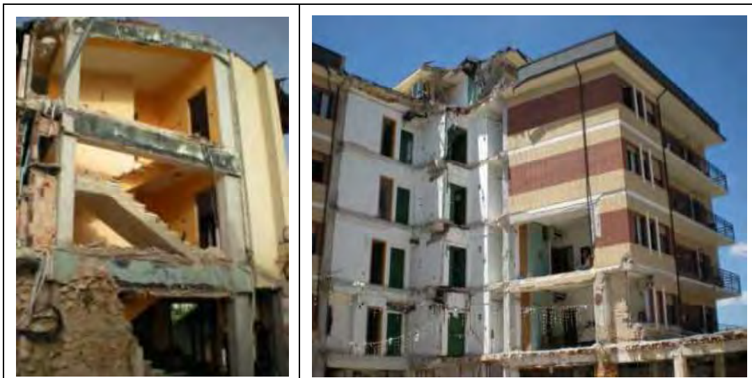
Figura 1 - Esempi di Crollo di Elementi Non Strutturali (L'Aquila 2009).
