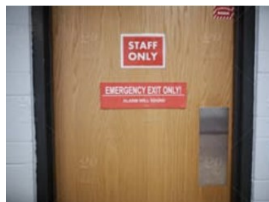
Figura 1.8.b. Esempio di scorretto uso del concetto di affordance , le scritte sono contraddittorie e non è intuitivo il verso di apertura della porta.
