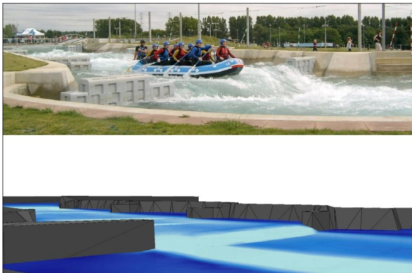
Figura 3.31 Particolare del 1° salto di fondo, prima dell'immissione nell'allargamento.
