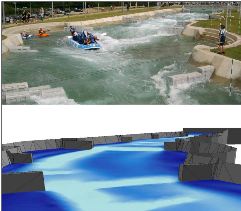
Figura 3.30 Secondo allargamento di sezione: foto scattata dal primo ponte di attraversamento del tracciato, da valle verso monte. In lontananza si scorge ancora il raccordo tra Start Pond e canale, in primo piano, invece, si ha il secondo restringimento dotato di salto di fondo, immediatamente a valle dell'allargamento.
