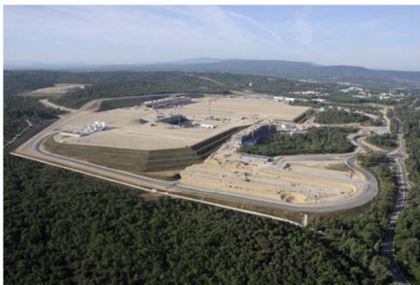
Figura 1-26: sito di costruzione del progetto ITER a Cadarache nel sud della Francia a settembre 2011
