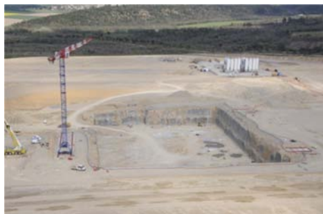
Figura 1-28: Febbraio 2011, è completato lo scavo per la costruzione della piattaforma antisismica dove costruire la camera del Tokamak
