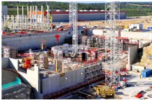
Figura 1-33: Aprile-Maggio 2015, stato dei lavori di costruzione dell'edificio di contenimento del Tokamak
