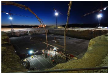
Figura 1-29: Agosto 2011, inizia la gettata per le fondamenta dell'edificio del Tokamak
