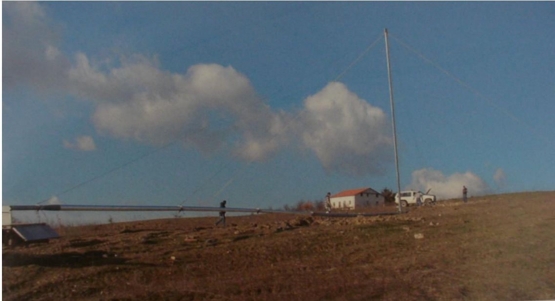
Figura 2.19 – Inizio sollevamento della torre
