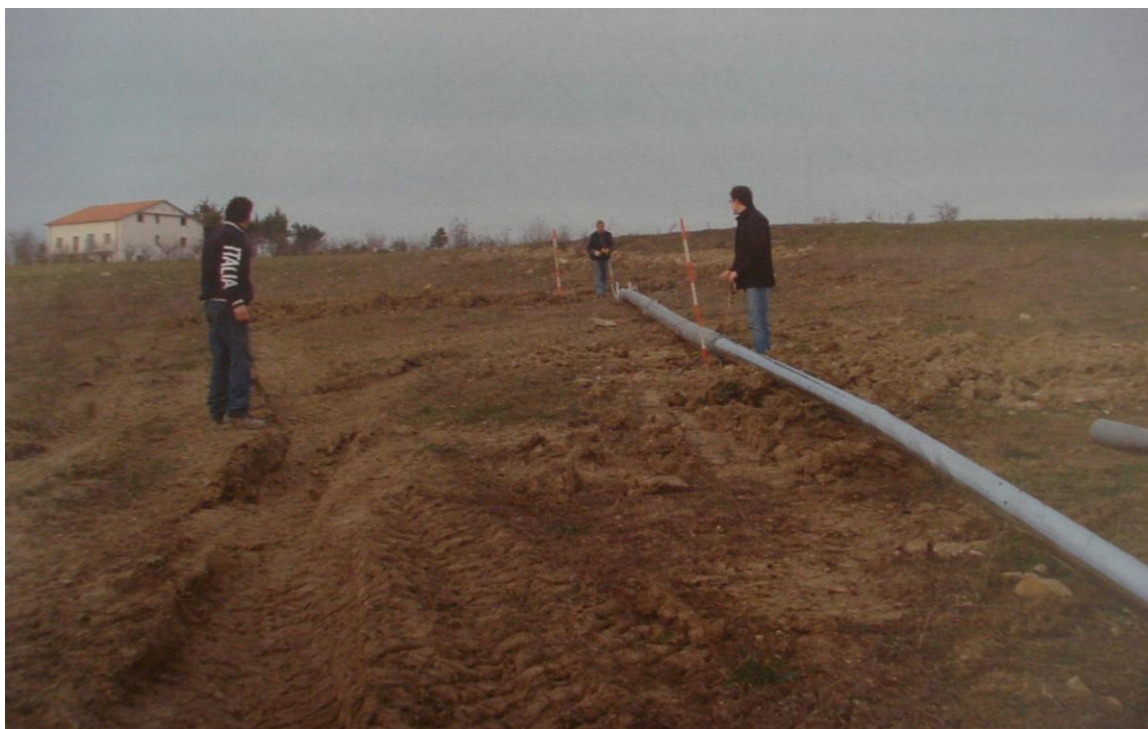
Figura 2.14 – Assemblaggio a terra della torre di sostegno
