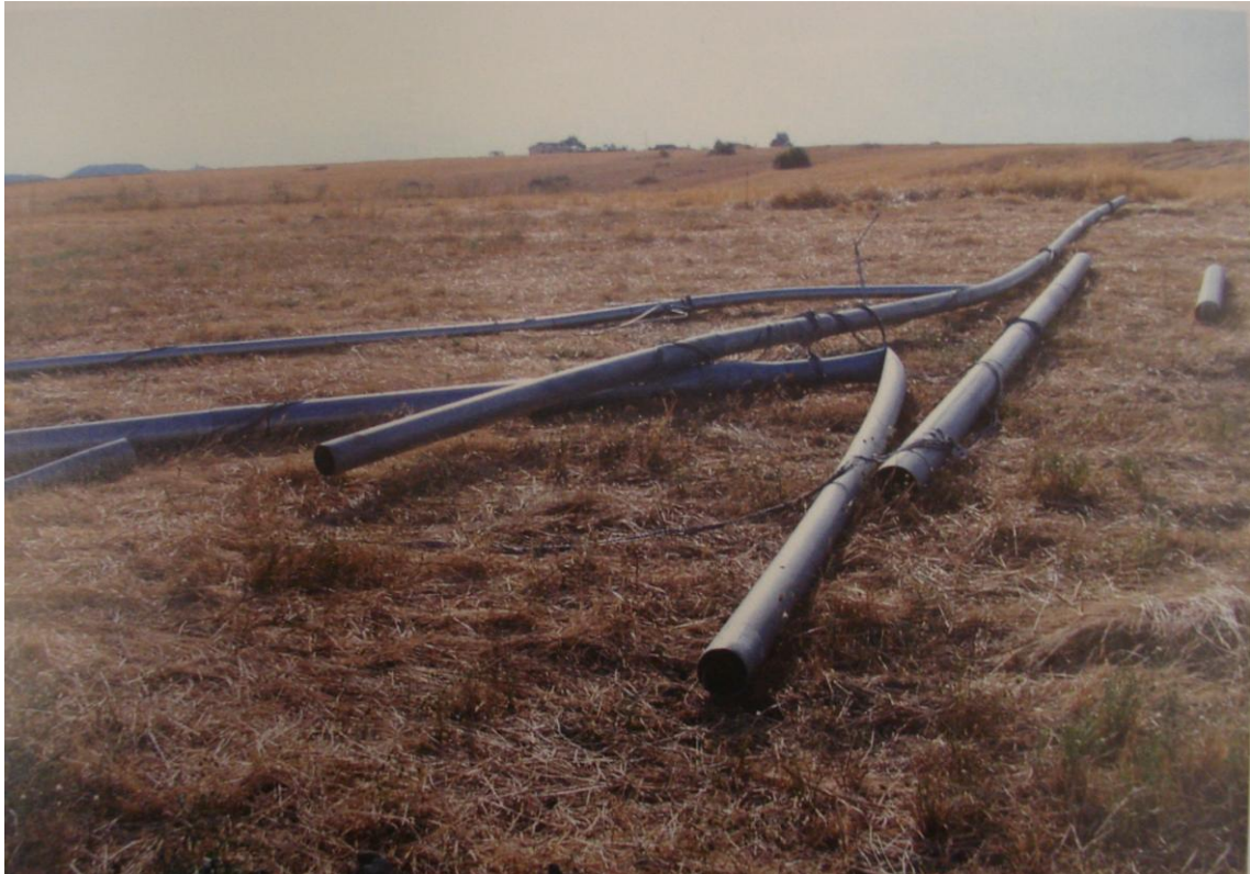
Figura 2.23 – Collasso di una stazione anemometrica in seguito ad una bufera di vento a 25 m/s (uno dei tiranti è ceduto per un difetto di installazione)
