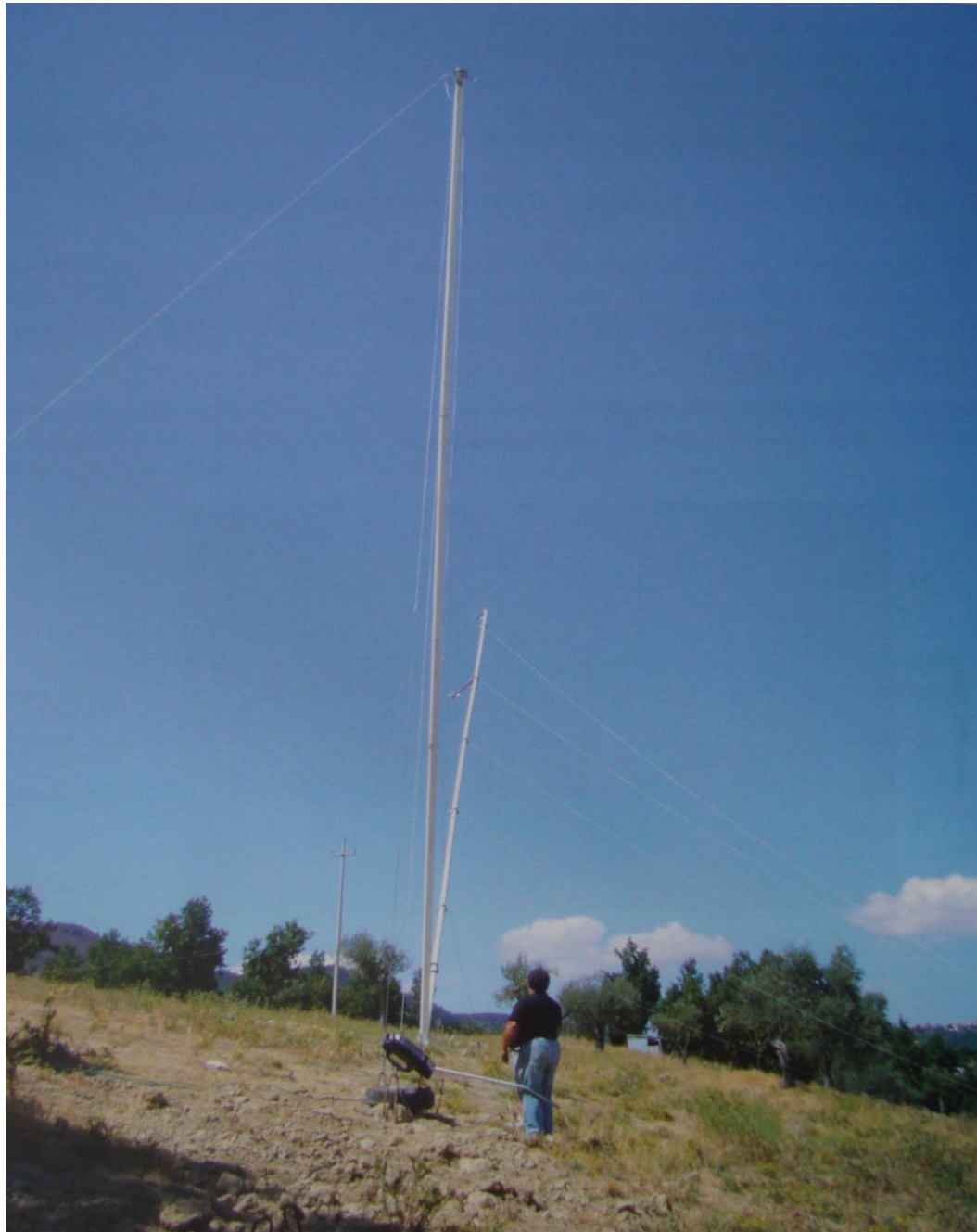
Figura 2.26 – Particolari dell'installazione della stazione anemometrica
