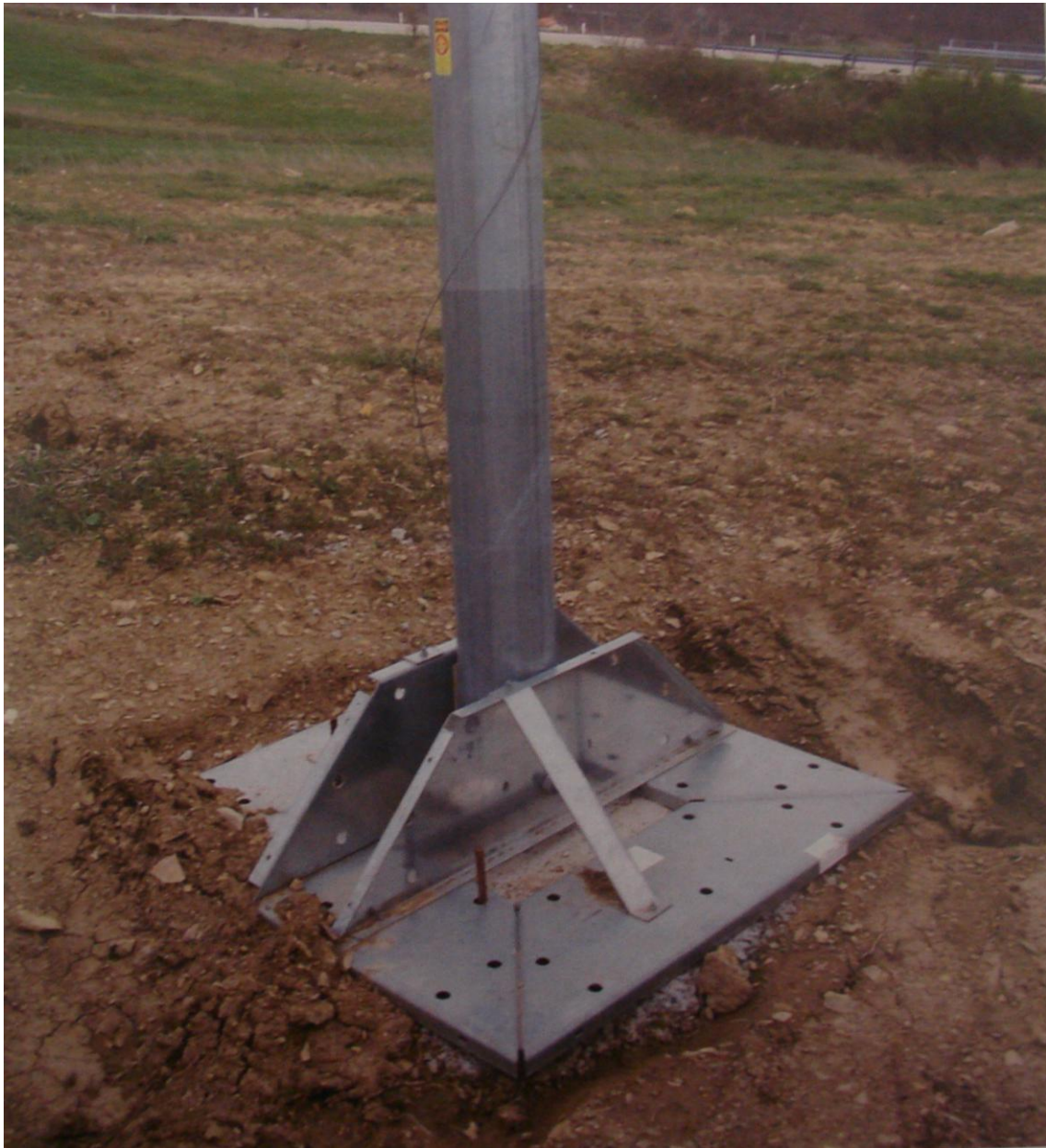
Figura 2.22 – Installazione su soletta in calcestruzzo
