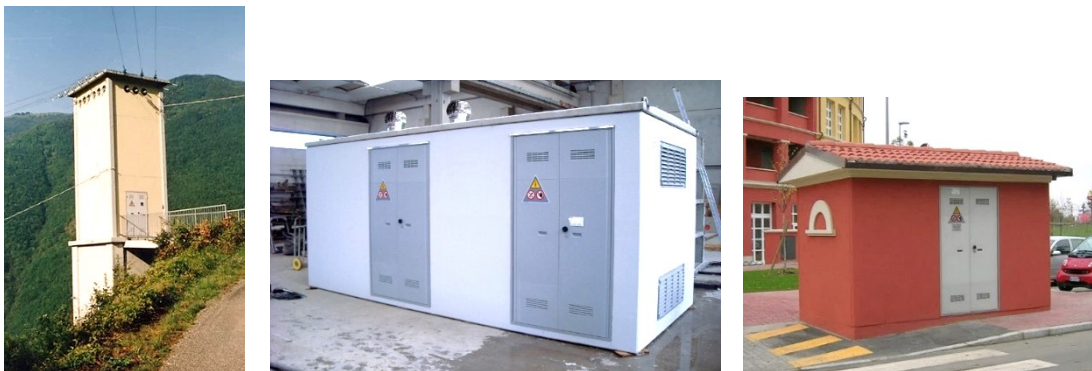
Figura 9 – Cabine secondarie a torretta (prima immagine) e a box (seconda e terza immagine)
