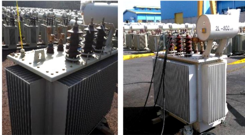
Figura 23 – Trasformatore di distribuzione ONAN da 500 kVA [12]
