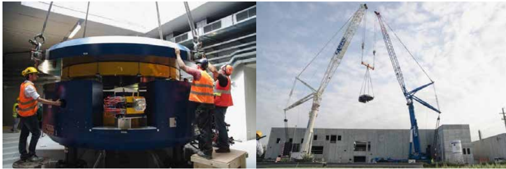
Fig. 1.7: Fasi di installazione del ciclotrone presso i L.N.L. (Maggio 2015)
