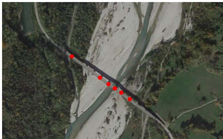
Figura 5.4: Intervento sulle pile di ponte Provagna a valle della zona industriale di Longarone.
