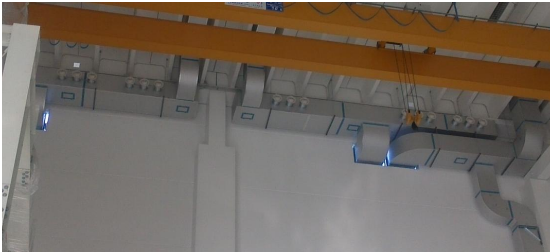
Figura 2.2.11: Alcune delle 36 bocchette di mandata
