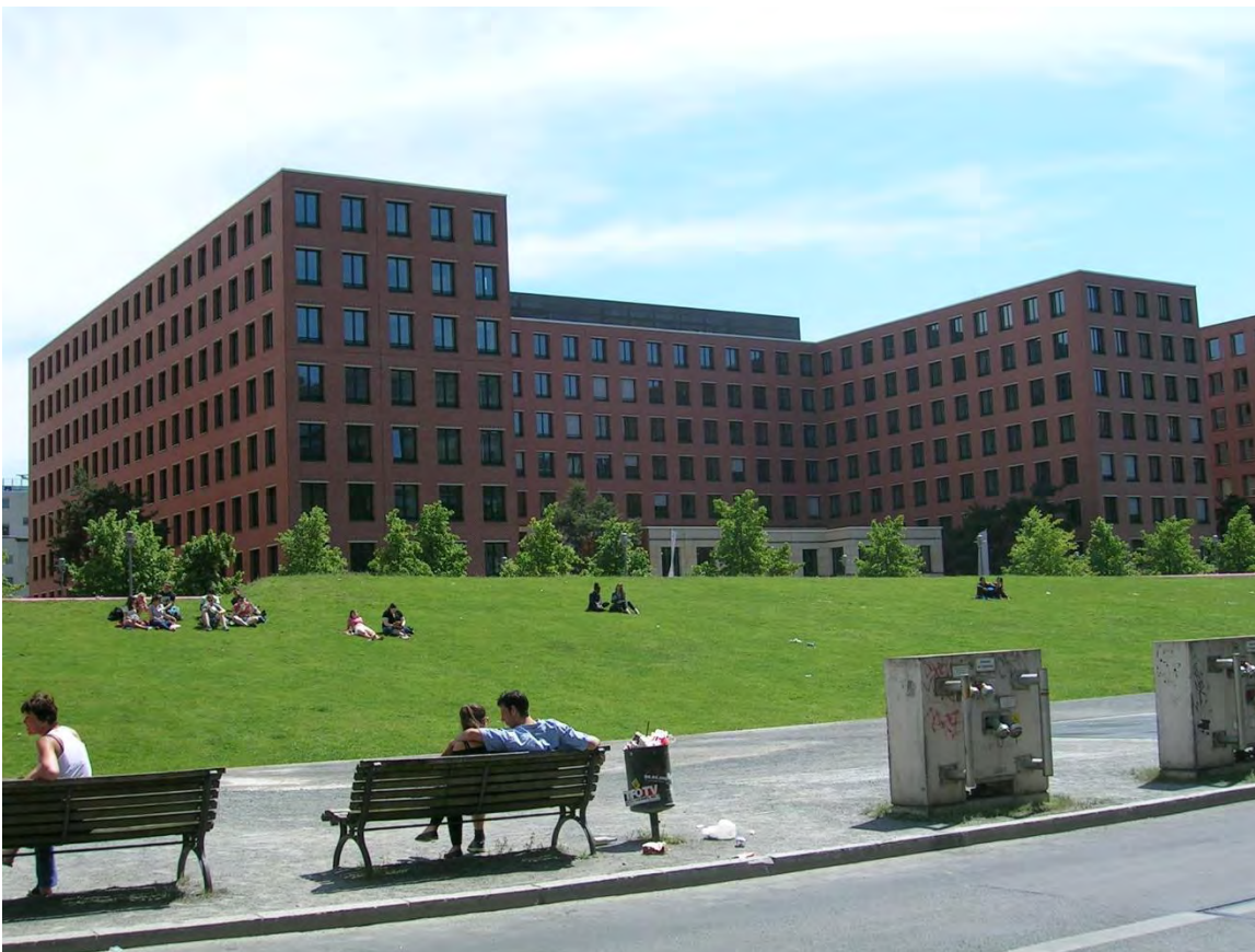
Figura 0.10 Vista di uno degli edifici progettati per Postdamer Platz
