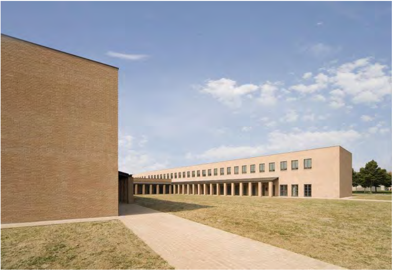
Figura 0.8 Vista della corte interna della Scuola di Noceto.
