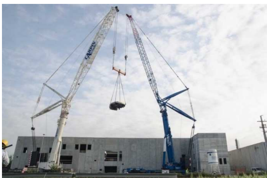
(a) Ciclotrone calato nel bunker.
