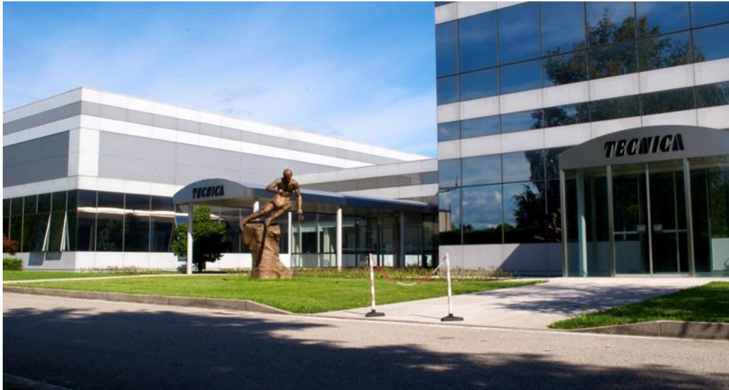
Fig. 1.1.3 L'Headquarter di Tecnica Group di Gavereto del Montello (Tv)
