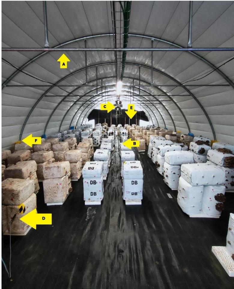
Figura 15 – Interno della fungaia A) Sistema di raffreddamento passivo, micro-sprinkler; B) Sensore fisso rilevatore di temperatura, umidità dell’aria, luminosità; C) Ventilatore assiale per ricircolo interno dell’aria; D) Sensore mobile inserito sulla singola unità produttiva; E) Sistema di raffreddamento attivo “Cooling system”; F) Trappola cromotropica per monitoraggio dei ditteri patogeni.
