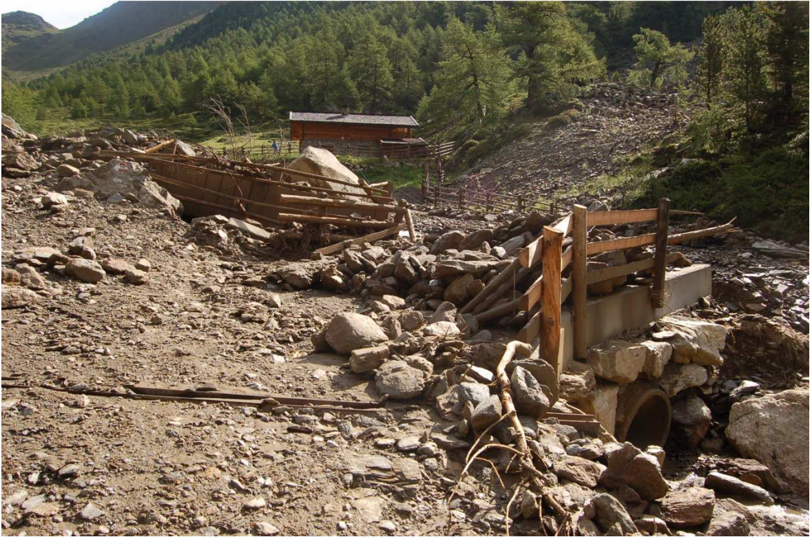
Figura 16: Danni alla strada di accesso a Malga Pastore.
