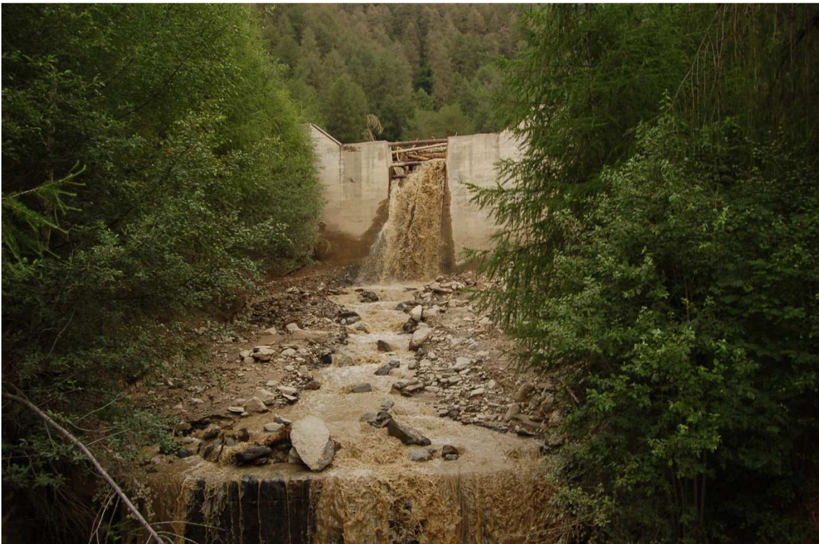
Figura 19: Briglia filtrante vista da valle. Il deposito di materiale è esiguo e interno al canale di smaltimento.
