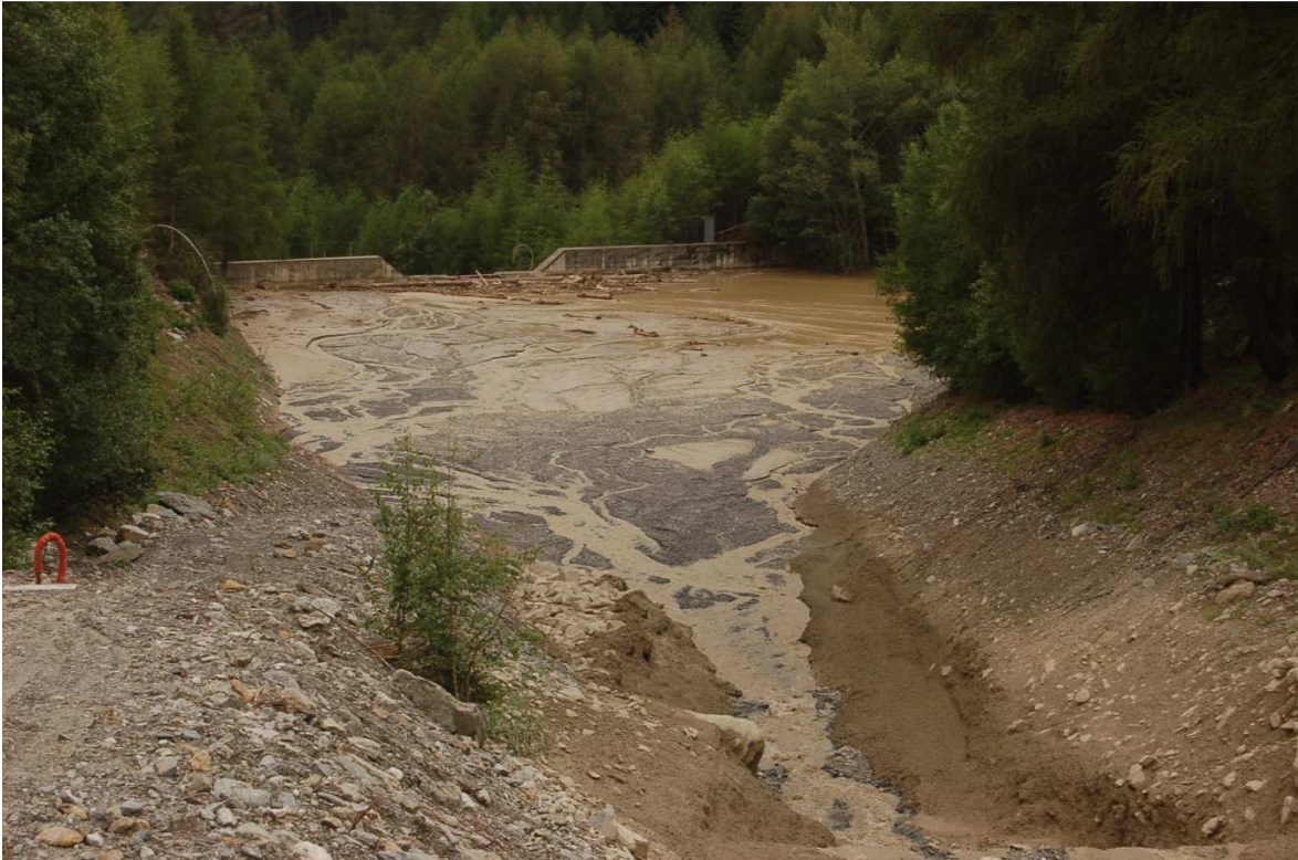
Figura 18: Briglia filtrante vista da monte in corrispondenza dell'immissione del rio Gabria. Il materiale vegetale è proveniente dal lariceto del rio Strimo.
