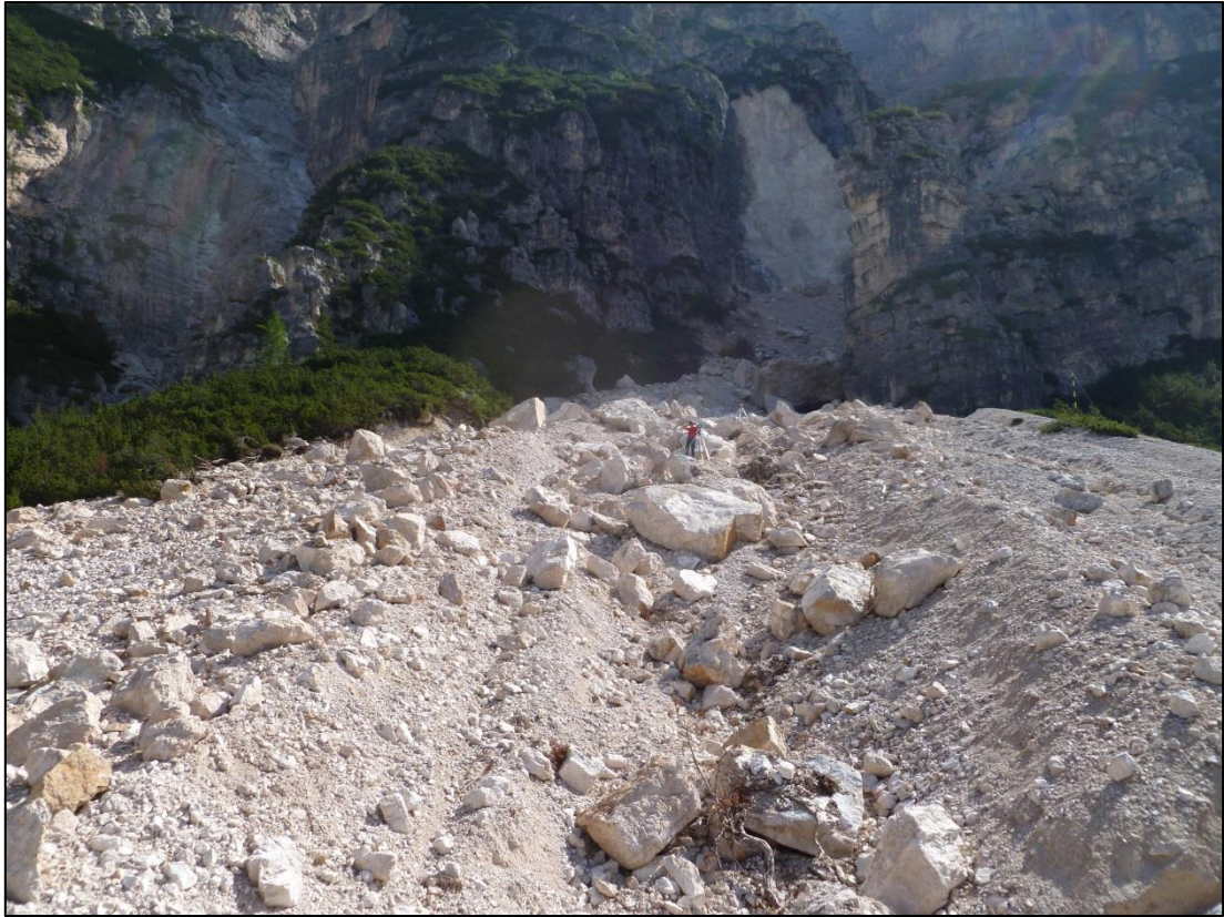
Fig. 3.5: Il canale "c08" visto da valle verso monte
