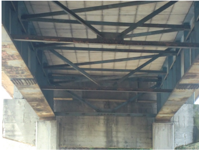
Figura 112: Vista dell'intradosso dell'impalcato
