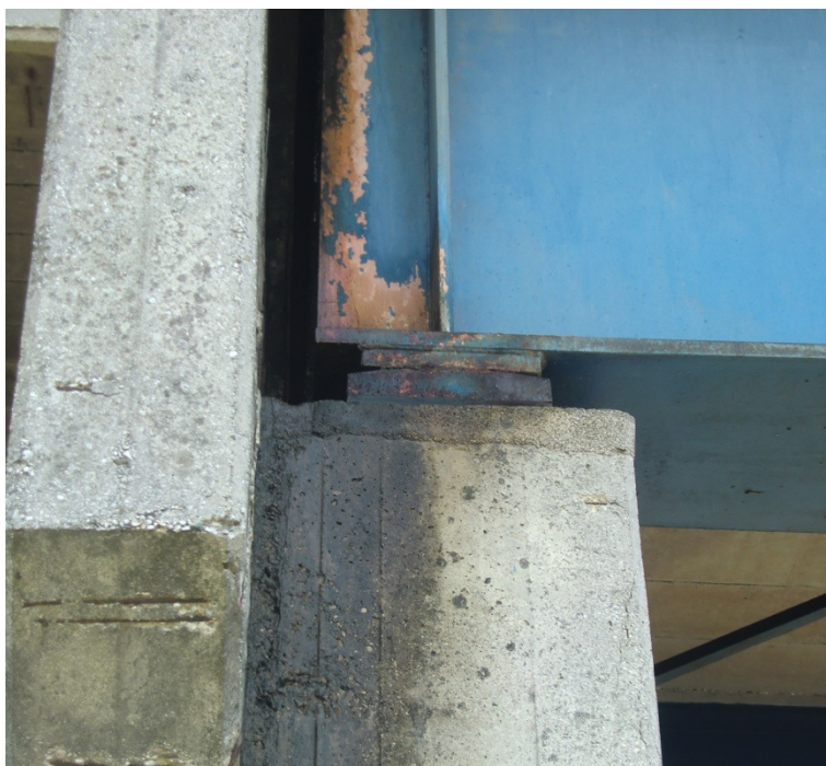
Figura 53: Zona di appoggio della trave metallica 1/2 - VIADOTTO 13
