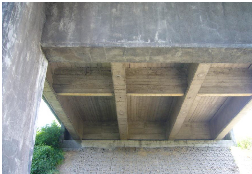
Figura 42: Vista dell'intradosso dell'impalcato – campata laterale - VIADOTTO 1
