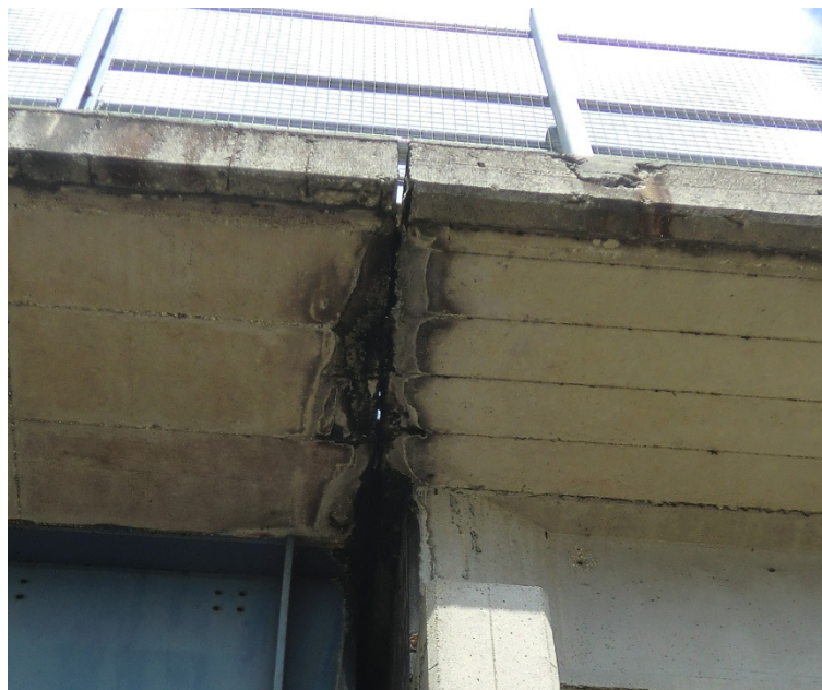
Figura 58: Vista del giunto dal piede della pila - VIADOTTO 13
