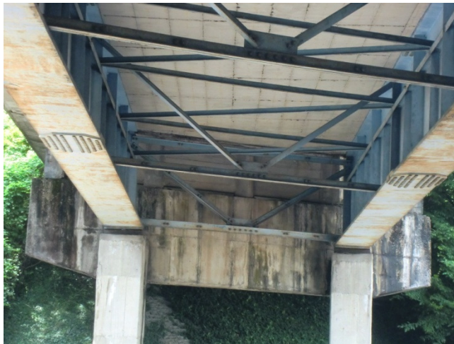
Figura 136: Vista dell'intradosso dell'impalcato
