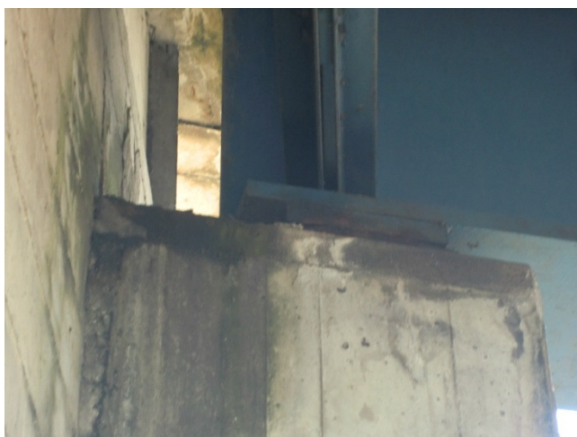
Figura 123: Particolare zona d'appoggio travi metalliche
