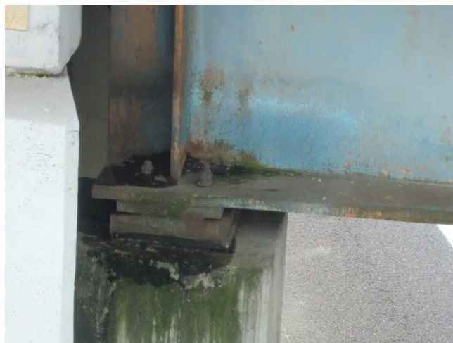
Figura 129: Particolare zona d'appoggio travi metalliche
