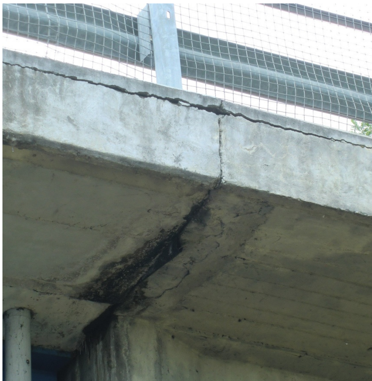
Figura 63: Cordolo in c.a. - VIADOTTO 26
