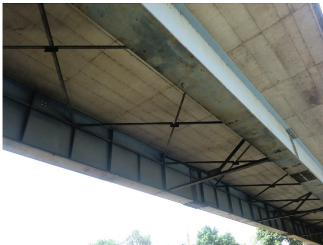
Figura 106: Vista dell'intradosso dell'impalcato
