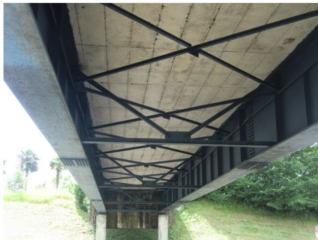
Figura 133: Vista dell'intradosso dell'impalcato
