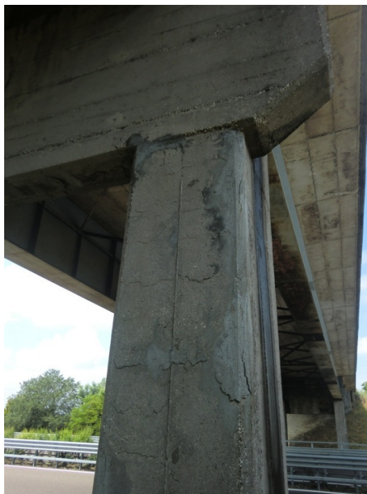
Figura 45: Vista della parte alta della pila: interventi di ricostruzione ammalorati - VIADOTTO 1
