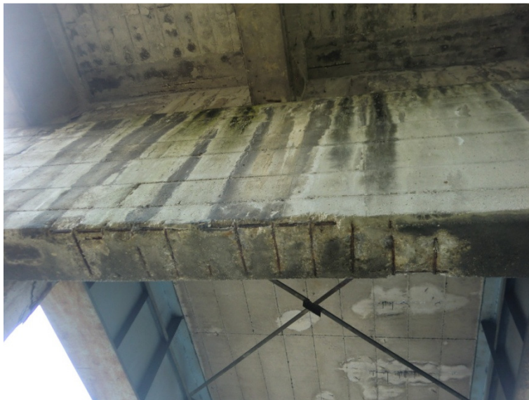
Figura 47: Pulvino - particolare armatura inferiore - VIADOTTO 13
