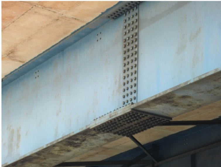
Figura 49: Travi i acciaio - particolare bullonatura - VIADOTTO 10
