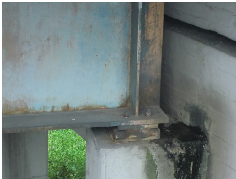
Figura 54: Zona di appoggio della trave metallica 2/2 - VIADOTTO 17
