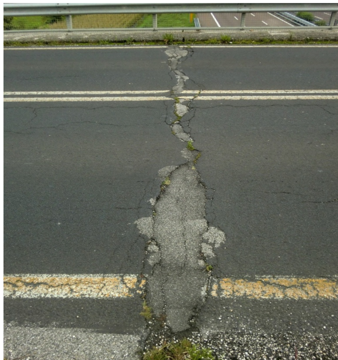
Figura 57: Giunto sottopavimentazione 2/2 - VIADOTTO 17
