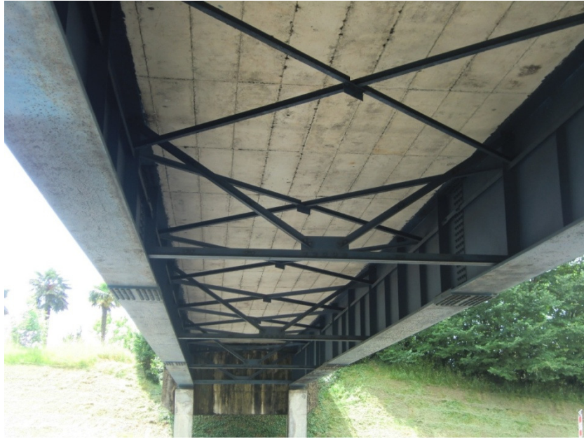
Figura 41: Vista dell'intradosso dell'impalcato – campata centrale - VIADOTTO 27
