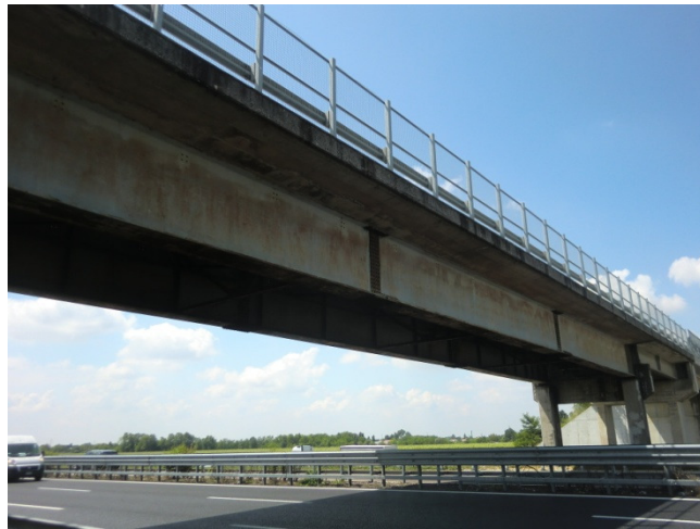
Figura 127: Travi in acciaio
