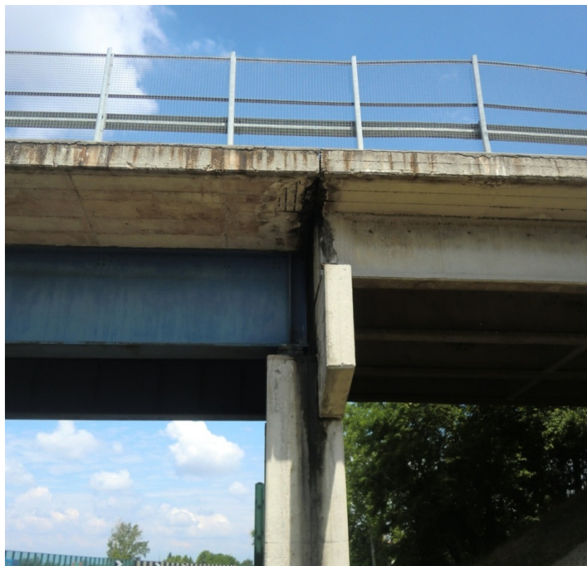
Figura 43: Particolare appoggio travi - VIADOTTO 10
