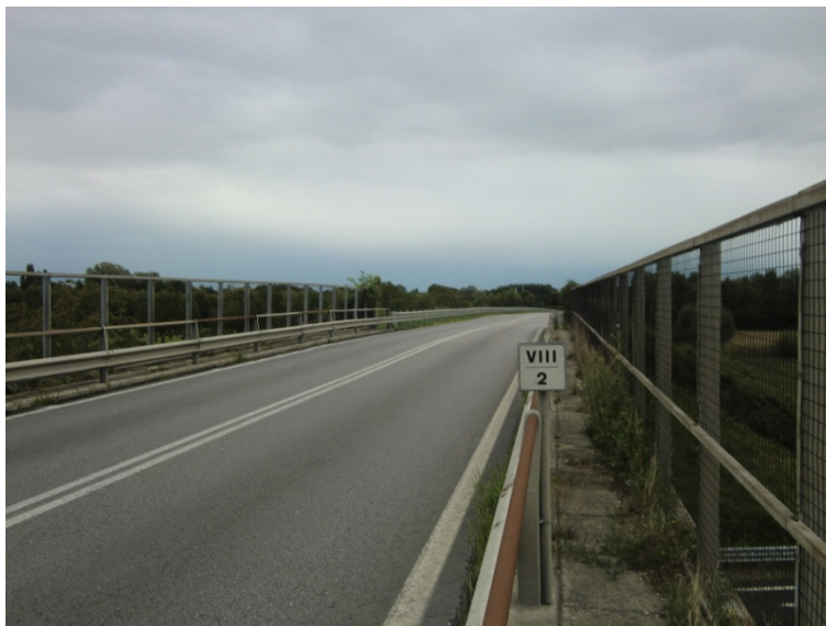
Figura 69: Guard-rail e parapetti - VIADOTTO 29
