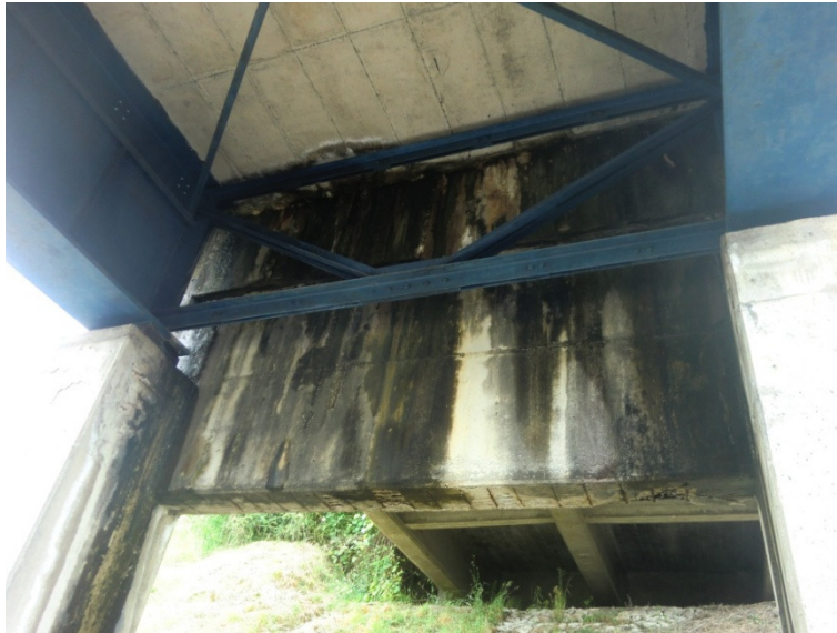
Figura 46: Pulvino – vista d'insieme - VIADOTTO 27
