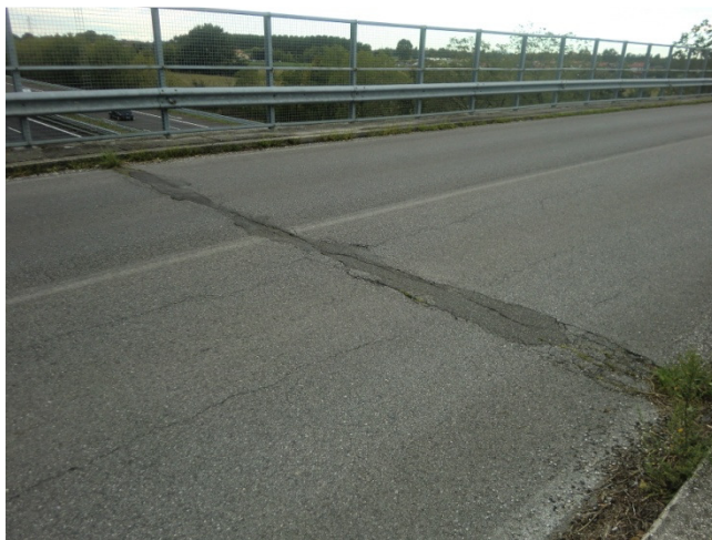
Figura 114: Giunto sotto-pavimentazione
