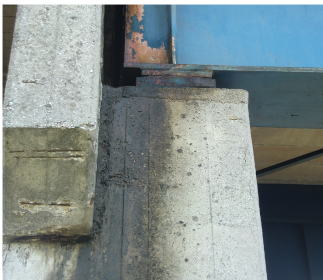
Figura 126: Particolare zona d'appoggio travi metalliche
