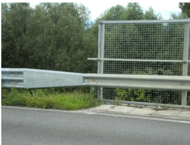
Figura 70: Particolare elemento di congiunzione tra elementi di ritenuta differenti - VIADOTTO 8
