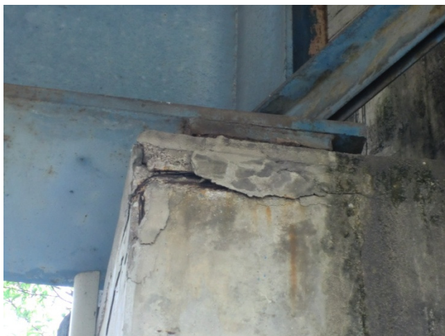
Figura 138: Particolare zona d'appoggio travi metalliche
