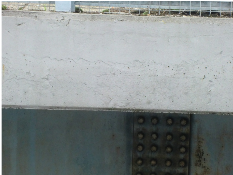
Figura 65: Particolare cordolo ripristinato - VIADOTTO 26
