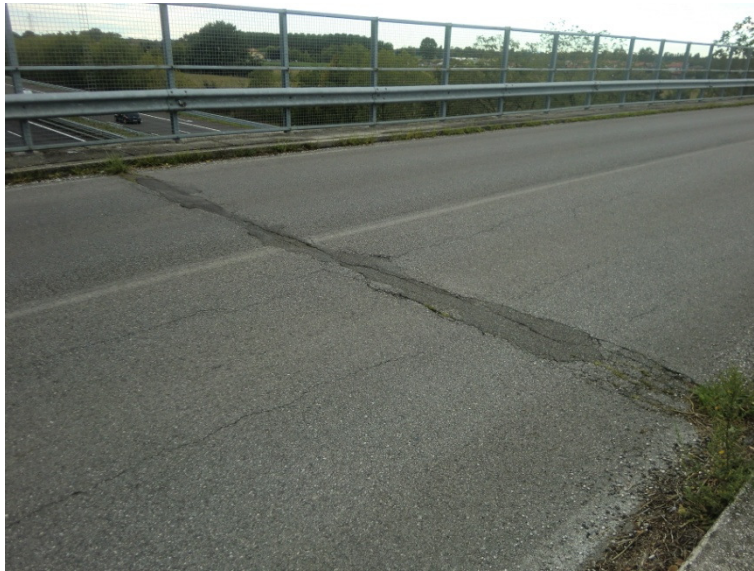
Figura 56: Giunto sottopavimentazione 1/2 - VIADOTTO 8
