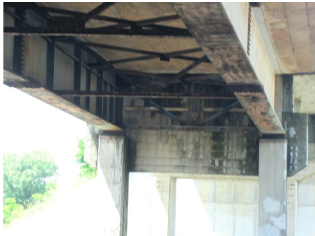
Figura 128: Vista dell'intradosso dell'impalcato
