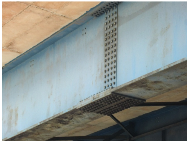
Figura 119: Travi in acciaio - particolare bullonatura
