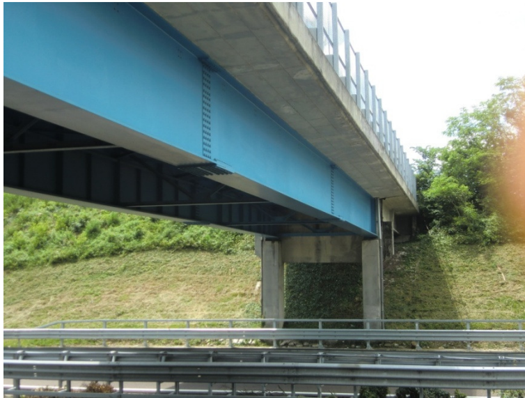
Figura 50: Travi in acciaio - elemento ripristinato - VIADOTTO 26
