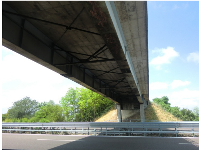
Figura 103: Vista dell'intradosso dell'impalcato
