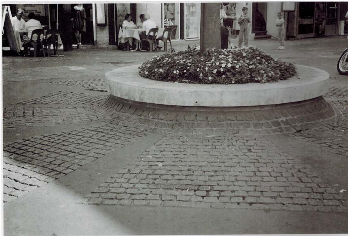
Fig. 27 – Raccordo per fioriera eseguito mediante pavé a elementi rettangolari. Caén (Francia).
