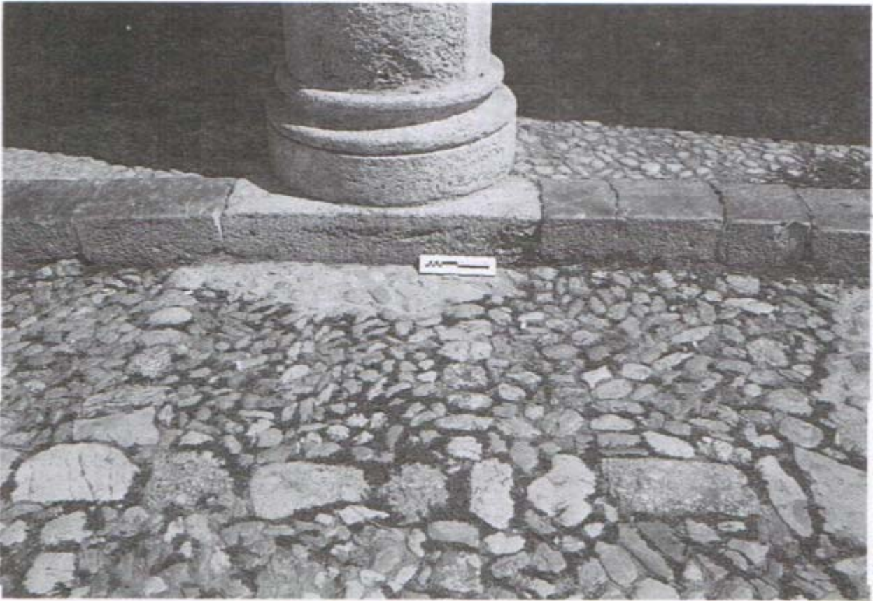
Fig. 4 – Pavimentazione in acciottolato, Norcia (PG).
