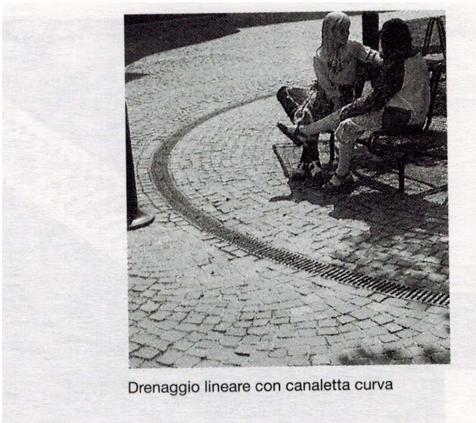
Fig. 8 – Sistema di drenaggio lineare ACO DRAIN.
