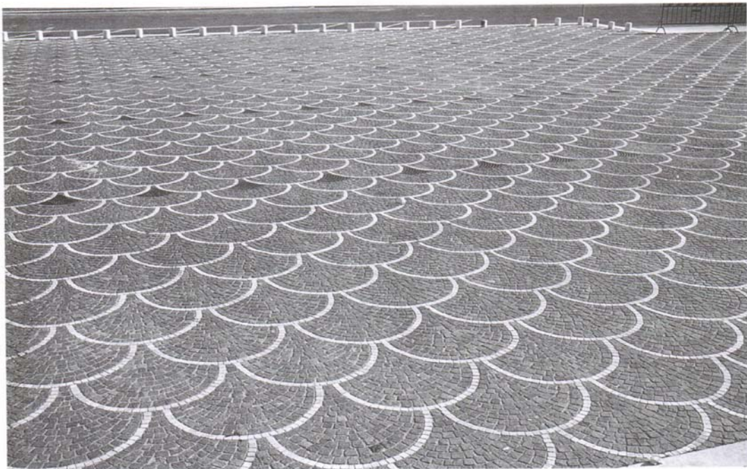
Fig. 23 – Pavimentazione in selciato: apparecchiatura a coda di pavone.
