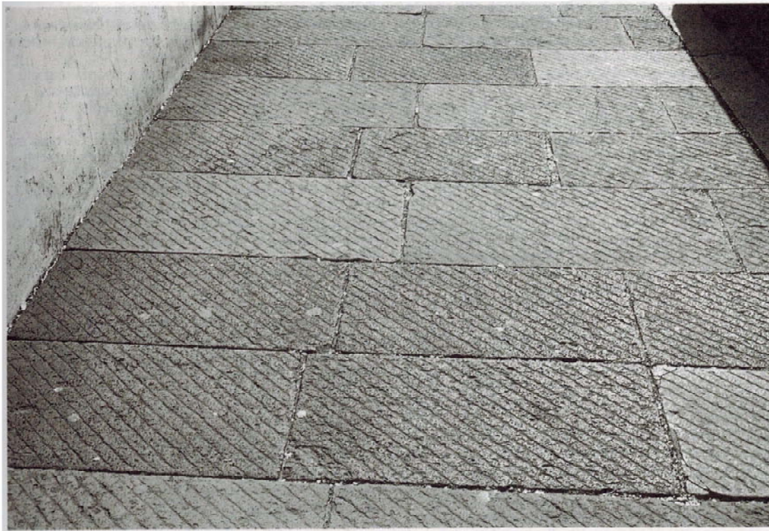
Fig. 38b – Lastricato in lava con superfici (50x70 cm) dotate d'incisioni oblique, ideali per sovrastrutture in pendenza (Roma).
