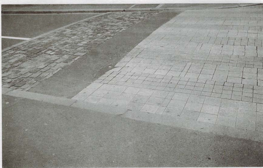
Fig. 52b – Attraversamento pedonale zebraato attuato in lastricato su carreggiata in conglomerato bituminoso. Il pavé in porfido, per la sua rugosità, è utilizzato nella fascia di segnalazione per veicoli.
