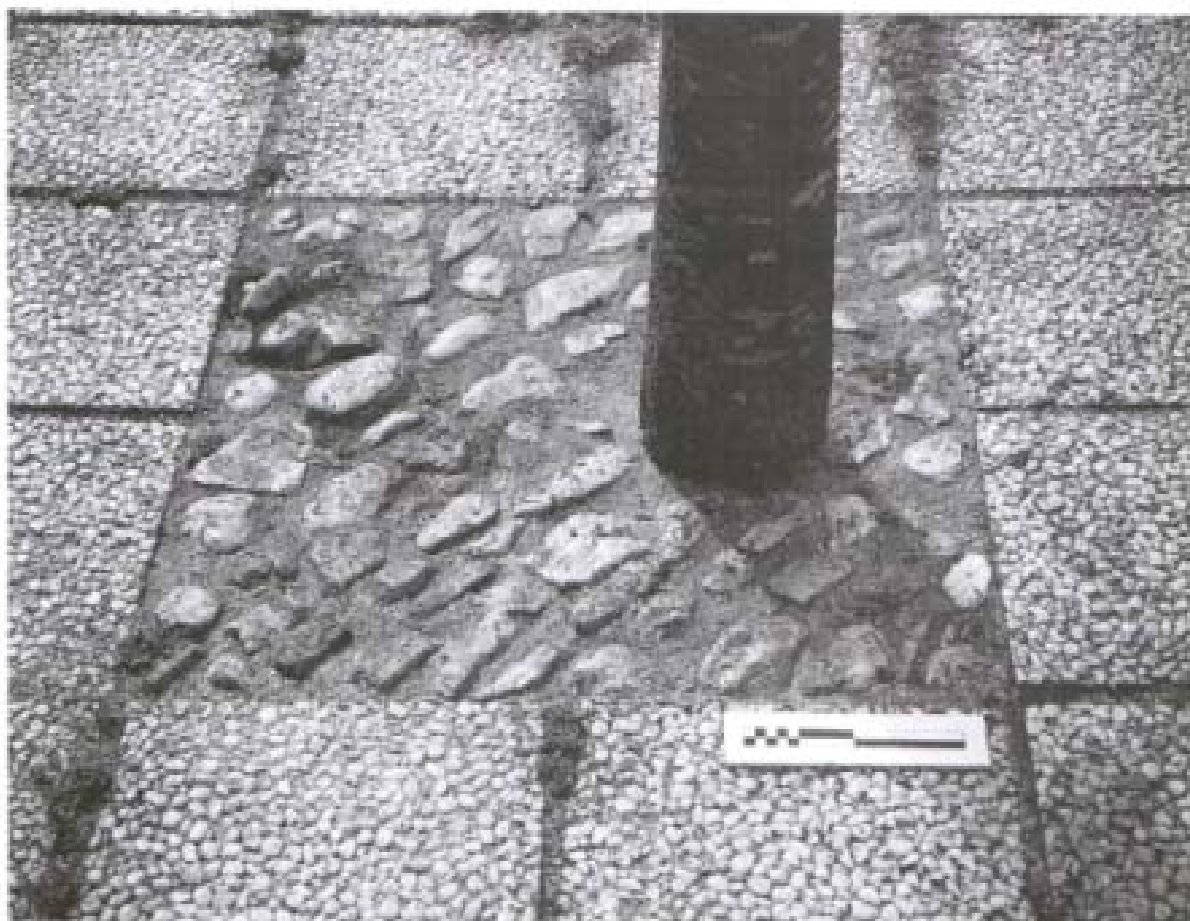
Fig. 3 – Elementi eseguiti con cemento e inerti naturali, posizionati attorno a un'area a ghiaia permeabile per permettere la sopravvivenza dell'albero.
