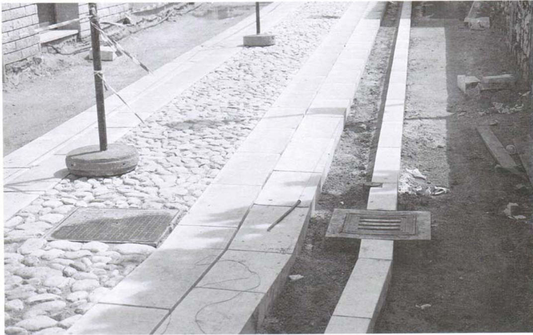
Fig. 14b – Strada acciottolata e trottatoi in pietra in fase di realizzazione. Piediluco (TR).
