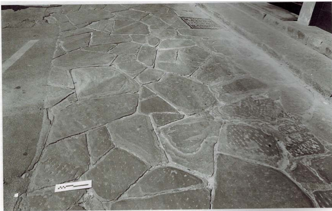
Fig. 45b – “Lastricato senz’ordine” in arenaria, impiegato nelle pavimentazioni fiorentine d’un tempo.
