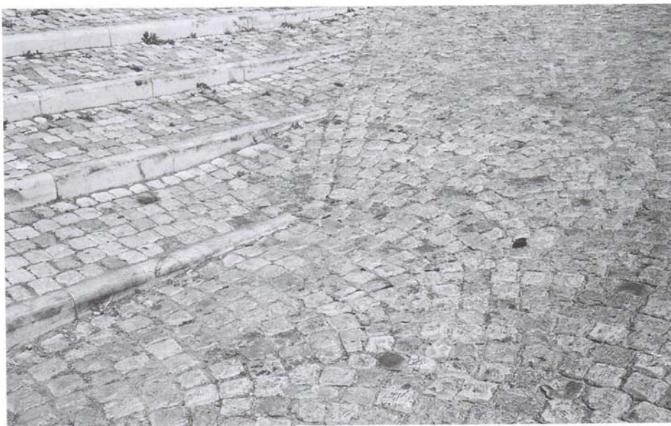
Fig.20b – Piazzale prospiciente Porta Rivera AQ). Pavimentazione in pendenza costituita da selci: la disposizione degli elementi ad archi contrastanti si congiunge con una gradonata eseguita a corsi dritti.
