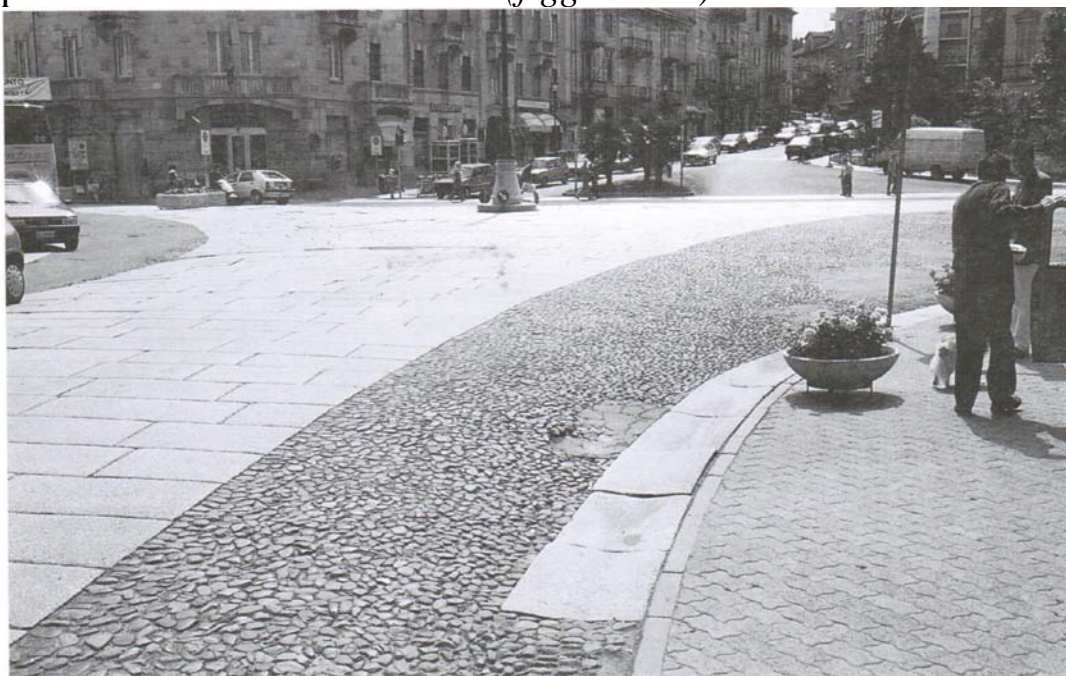
Fig. 14a – Lastricato situato nel centro della sede stradale, per permettere agli utenti dei veicoli una confortevole percorribilità; l'acciottolato è invece disposto lateralmente. Acqui Terme (AL).
