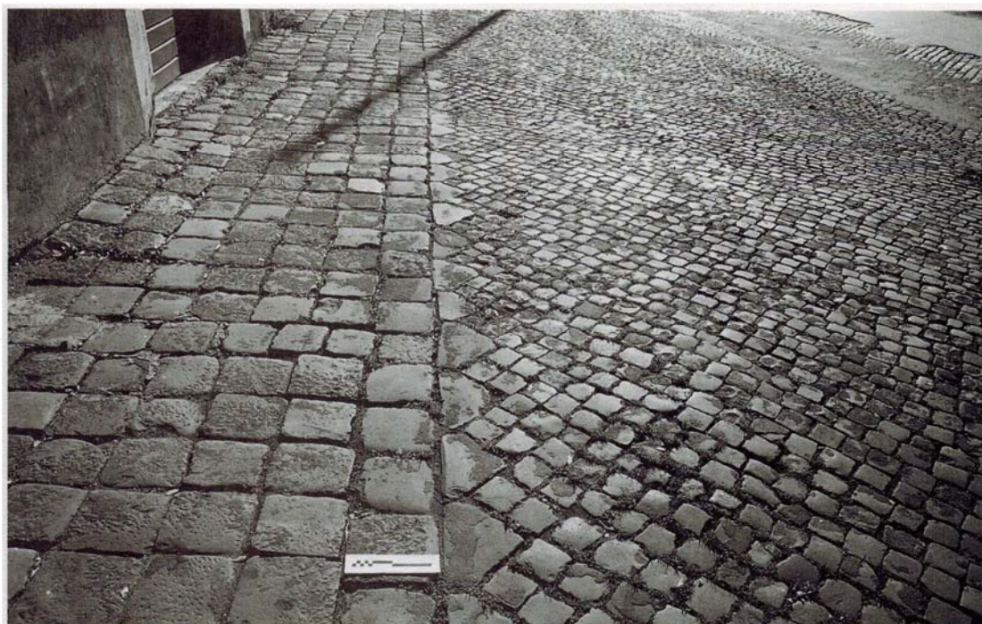
Fig. 24 – Pavimentazione in selciato (apparecchiatura a corsi rettilinei).
