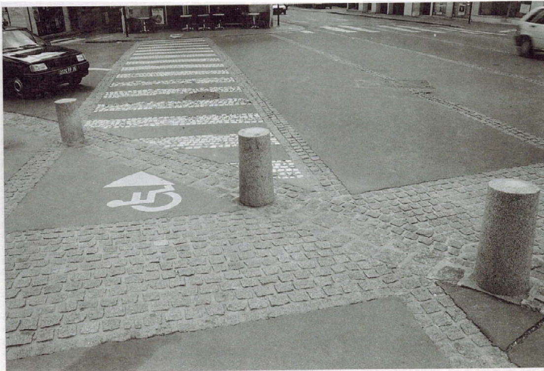
Fig. 46 – Caén (Francia). Dissuasori per veicoli e inserzioni varie del pavé sul fondo di conglomerato bituminoso a guisa di segnaletica.
