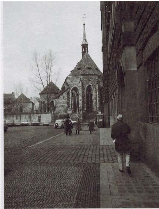
Fig. 29a – Praga (Czech Republic). Marciapiede in selciato con cubetti di granito e porfido a costituire riquadrature delimitate dai lastricati dei passi carrabili.
