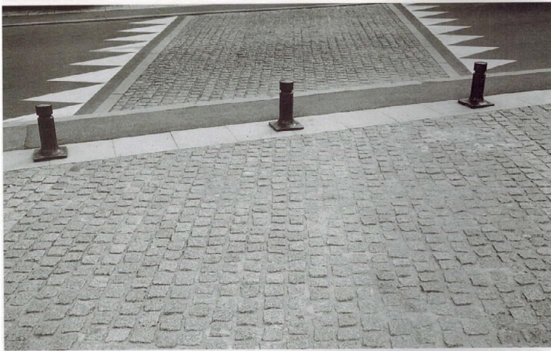
Fig. 47a – Rezé Le Nantes (Francia). Attraversamento pedonale in pavé su carreggiata in conglomerato bituminoso e paracarri metallici.
