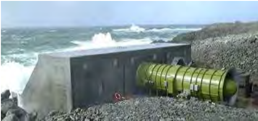
Fig. 3.5 – Foto dell'impianto LIMPET
