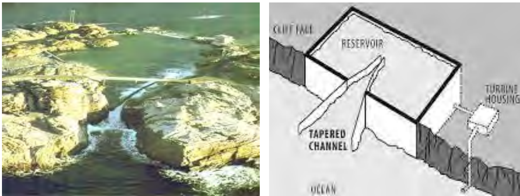
Fig. 3.1 – Tapchan realizzato in Norvegia a Toftestallen nel 1985, a destra relativo schema di principio
