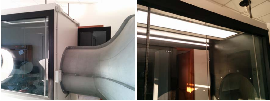
Figura 4.14. Impianto elettrico per l'illuminazione della camera di prova.
