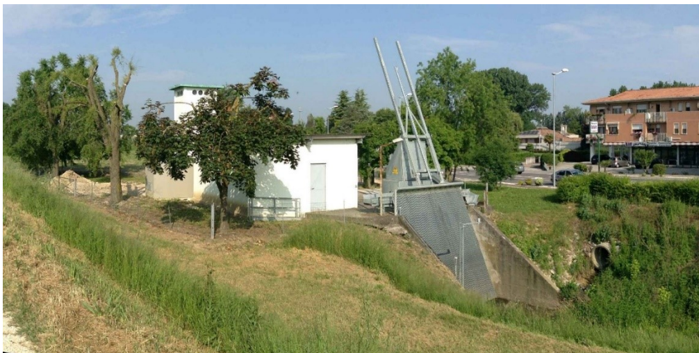
Fig. 10: Impianto Fossa dei Negadi
