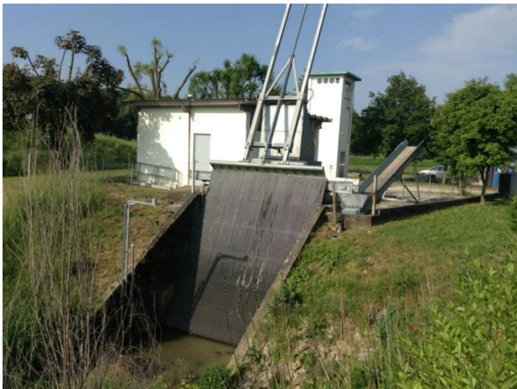
Fig. 11: Manufatto d'ingresso preceduto da griglia e sgrigliatore
