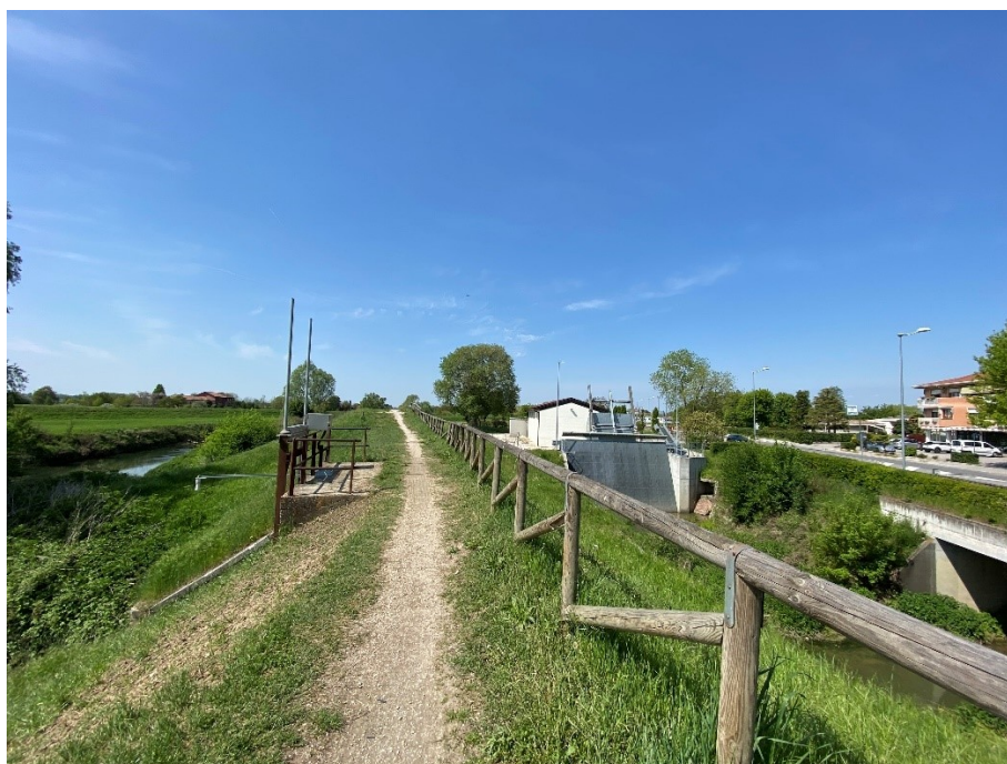
Fig. 29: Da sinistra a destra: paratoia, argine, impianto, sottopassaggio del canale, 2022
