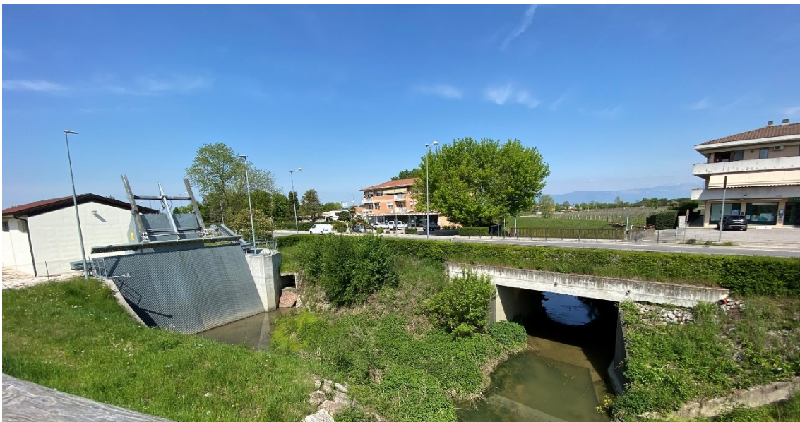
Fig. 8: Sottopasso dello scolo Fossa dei Negadi sotto la Strada Regionale 53, 2022
