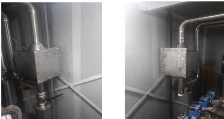
Figura 4.14: nuovo sistema di filtraggio ingresso motore
