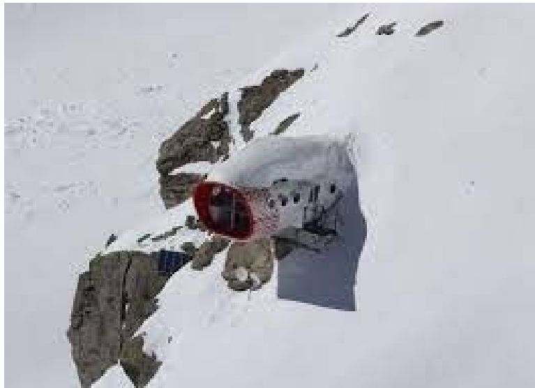
Fig 13: Bivacco Giusto Gervasutti , Courmayeur (IT), 2835 mslm. Anno di costruzione :2012.
