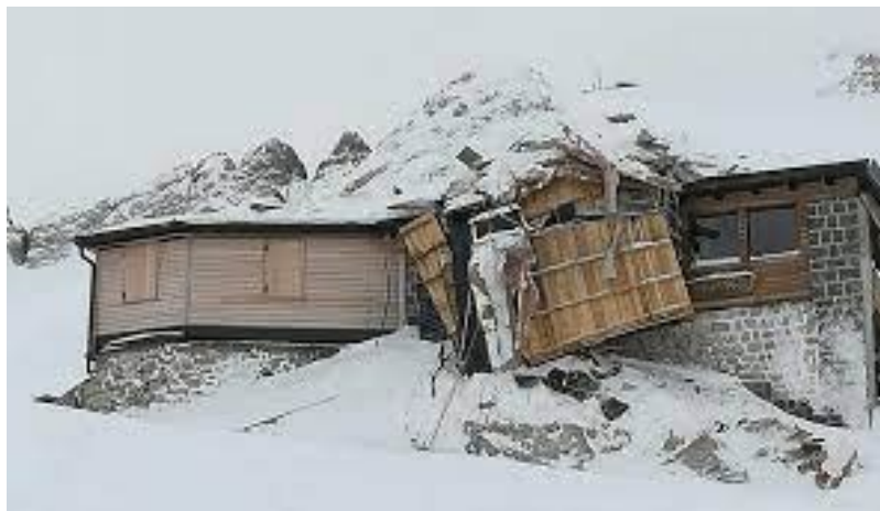
Fig. 21: Il vecchio rifugio di Pian dei Fiacconi distrutto da una valanga. Anno:2020.
