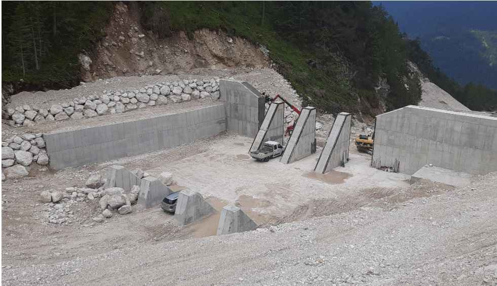
foto n.4 – Briglia frangicolata sul torrente Ru Secco con elementi in calcestruzzo, San Vito di Cadore (foto dell'autore).
