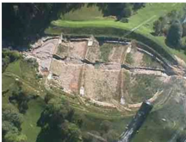
foto n.10 – Piazza di deposito con setti in terra – Vallescura, BG (tratto da Atlante delle opere di sistemazione fluviale, APAT 2003).
