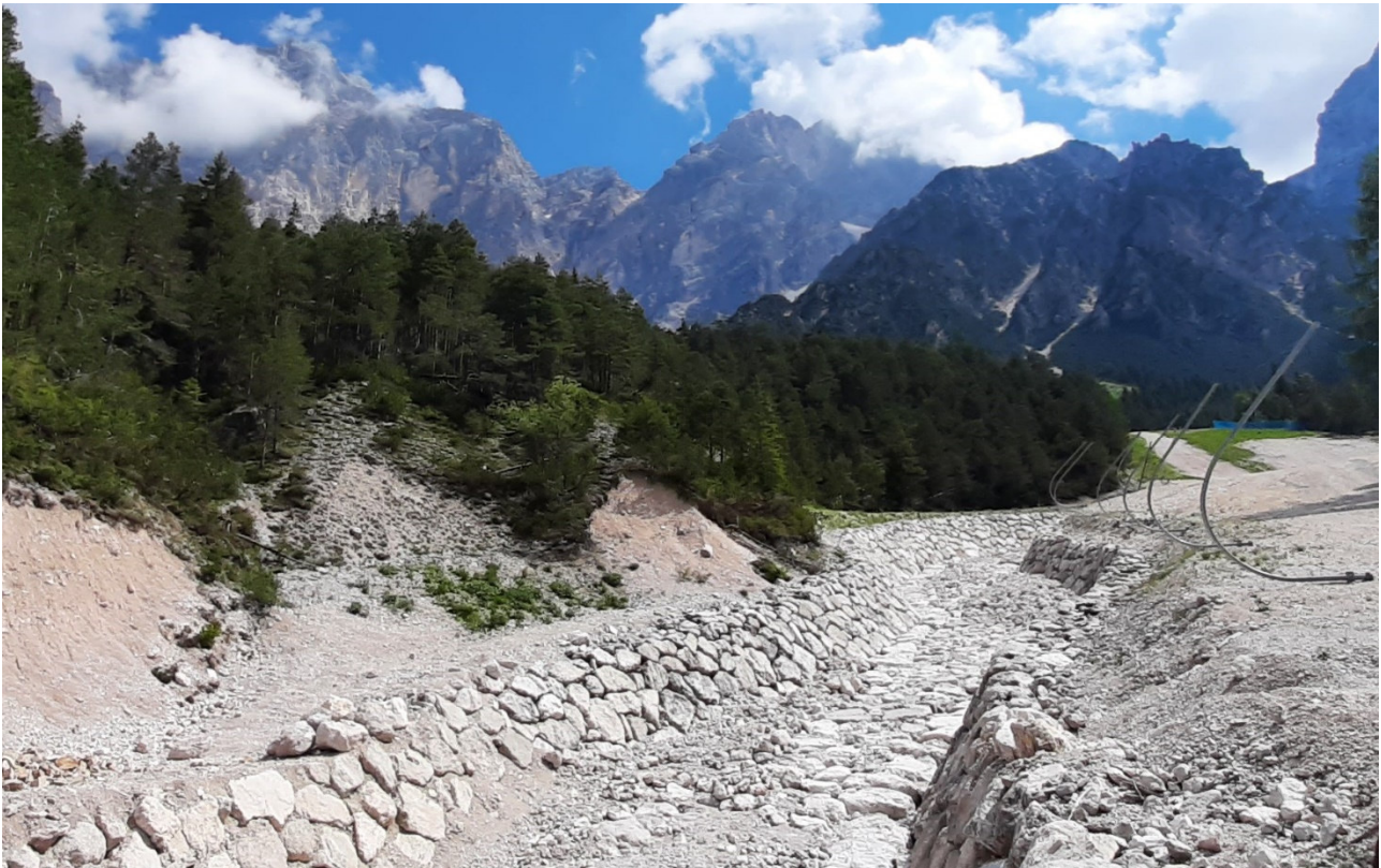
foto n.1 – Muri di sponda e corazzatura di fondo sul torrente Ru Secco, San Vito di Cadore (foto dell'autore).
