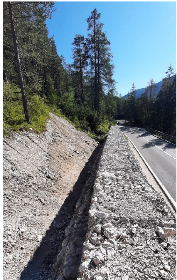
foto n.9 (a lato) – Muro in gabbioni posto a protezione della S.S. n.51 dal soprastante deposito di colata detritica in località Fiames (foto dell'autore).
