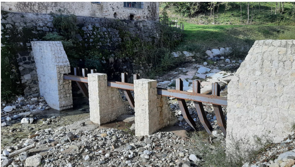
foto n.6 – Briglia filtrante in profilati metallici, affluente di sinistra torrente Timonchio, Santorso (foto dell'autore).
