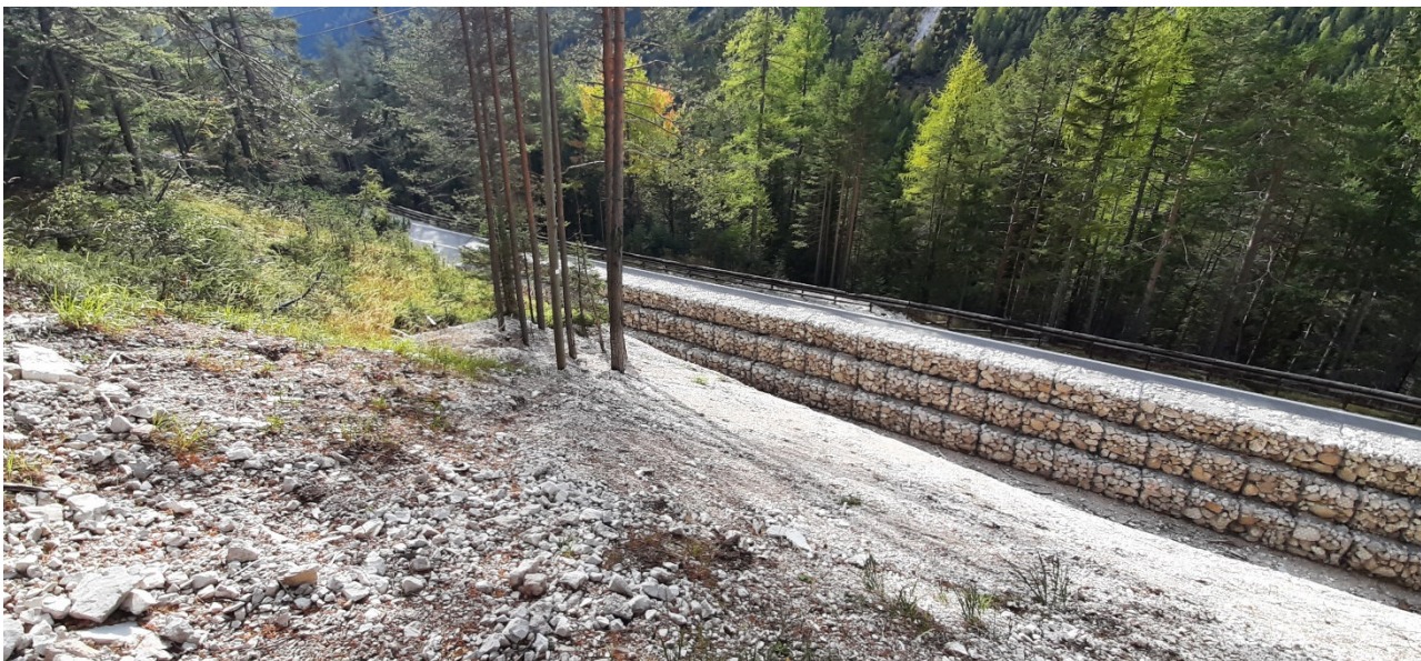
foto n.31 – Muro in gabbioni visto dal deposito detritico, da notare lo scavo per la formazione di un volume di accumulo tra il muro in gabbioni ed il versante (foto dell'autore).
