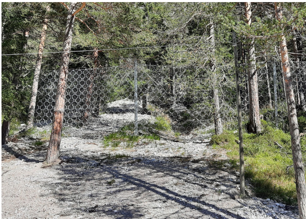
foto n.7 – Barriera metallica installata su precedente colata in località Fiames (foto dell'autore).
