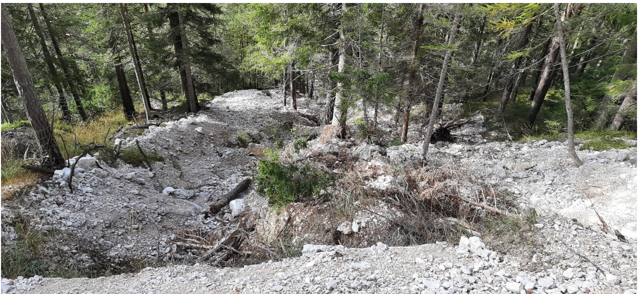
foto n.22– Deposito detritico del canale C18 lato a valle della pista ciclabile con visibili profonde erosioni, tra i detriti si rinviene legname e piante intere (foto dell'autore).
