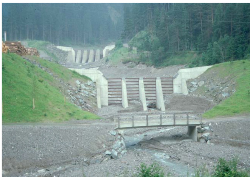
foto n.15 – Opere di uscita dal bacino di contenimento, briglia frangicolata a speroni sullo sfondo e briglia filtrante a fessura in primo piano (Lienz, Austria).
