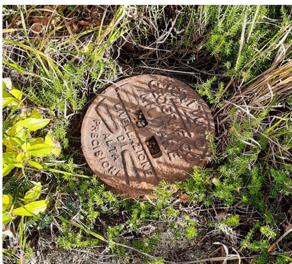
Foto n.34 – Coperchio in ghisa a protezione del caposaldo di livellazione orizzontale ubicato presso il Km109 della S.S.n.51 di Alemagna – CS n.0039#_###_036# (foto dell'autore).
