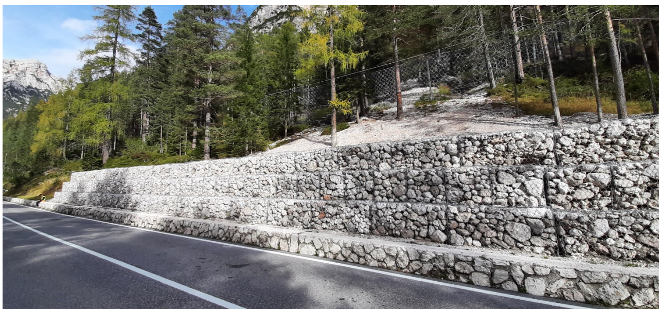
foto n.30 – Opere provvisorie di protezione: muro in gabbioni e reti paramassi (foto dell'autore).
