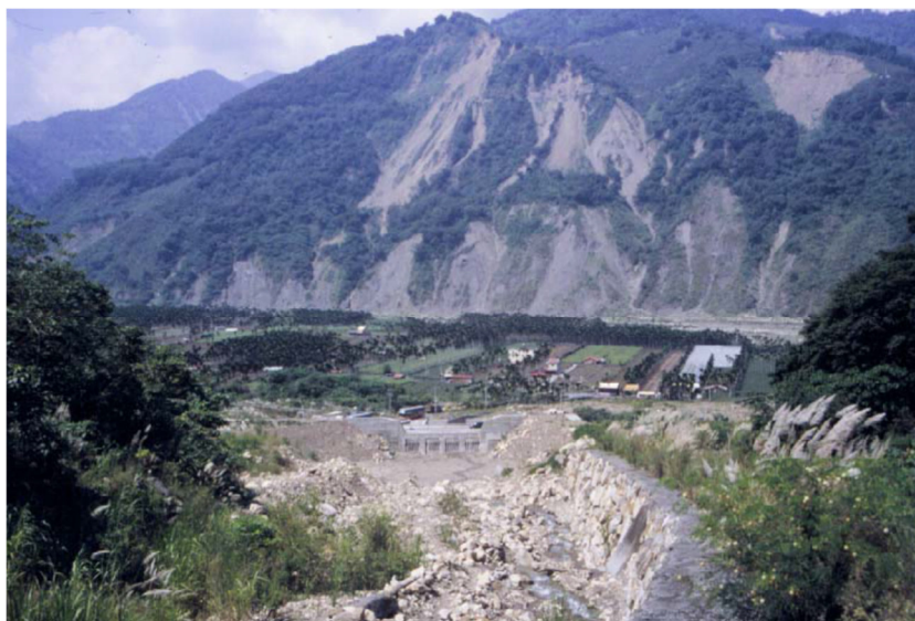
foto n.13 – Barriere di contenimento detriti, Western Taiwan.
