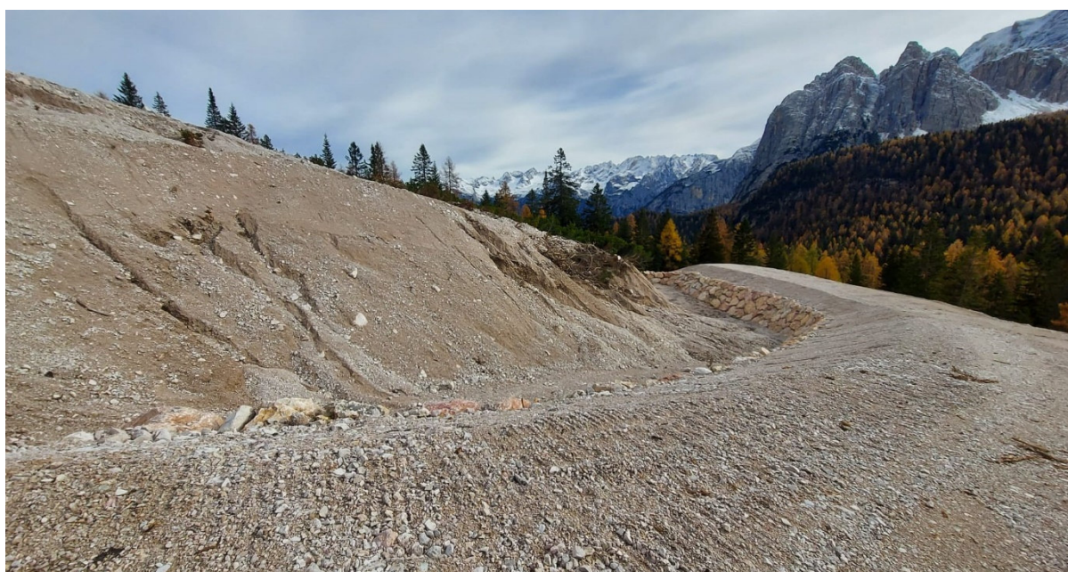
Foto n.8 – Argine a protezione della S.R. n.48 sul Passo Tre Croci, Cortina d'Ampezzo. (foto di Carlo Gregoretti).
