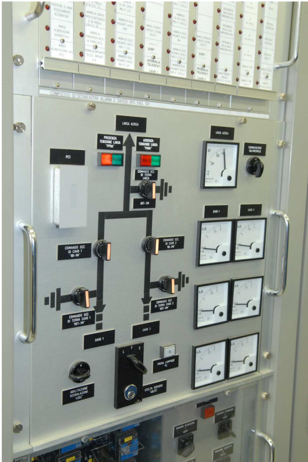
Pannello di Servizio Protezione Comando e Controllo
