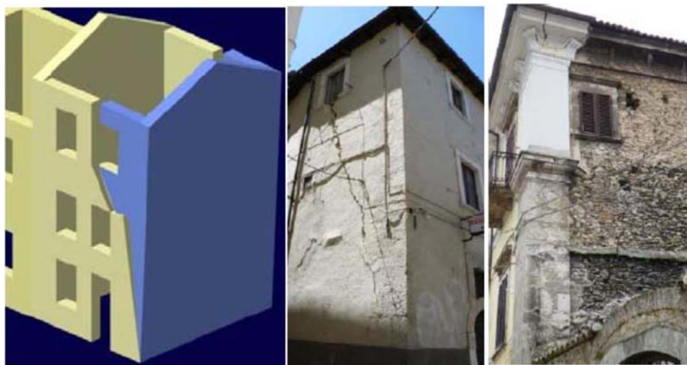
Fig. 2.3 Schema ed esempio di ribaltamento composto
