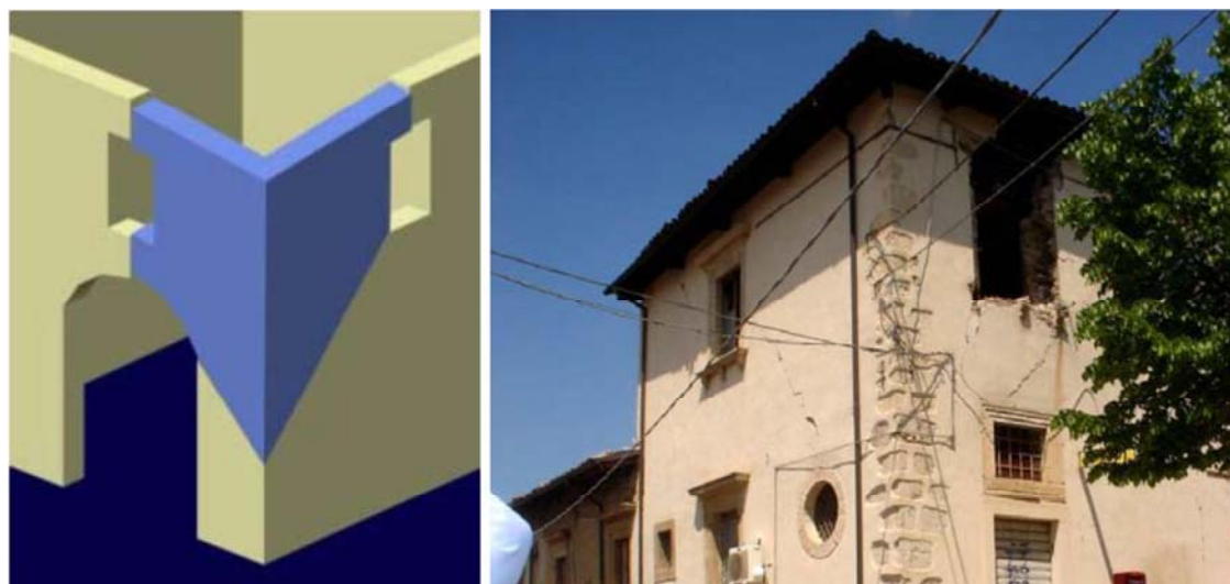
Fig. 2.3 Schema ed esempio di ribaltamento composto
