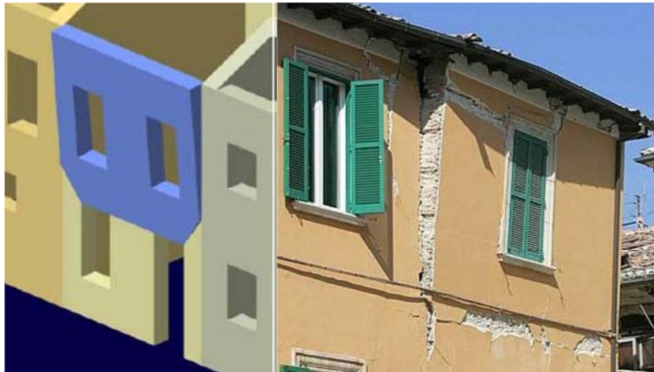
Fig. 2.2 Schema ed esempio di ribaltamento semplice di parete posta all'ultimo piano
