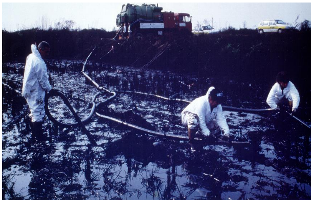
Figura 1.5 - Rimozione del petrolio greggio presente sulla superficie.
