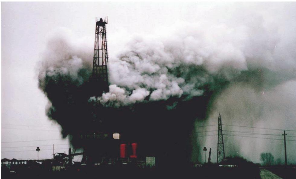
Figura 1.3 - Esplosione pozzo Trecate 24 (TR24).
