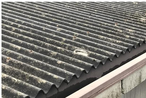
**Figura 2.11.** Esempio di copertura in amianto
