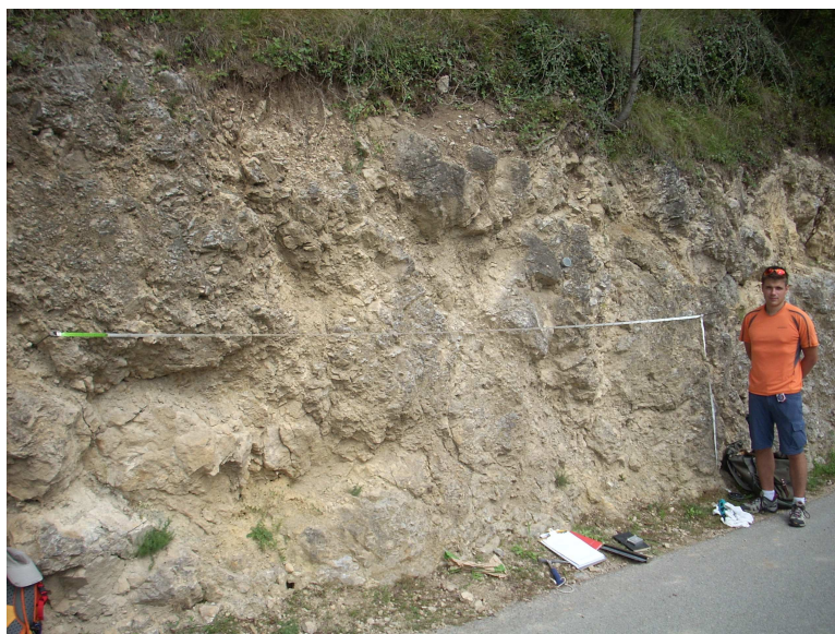
Fig. 5-1: Stazione geomeccanica effettuata sulla Formazione di Buchenstein.
