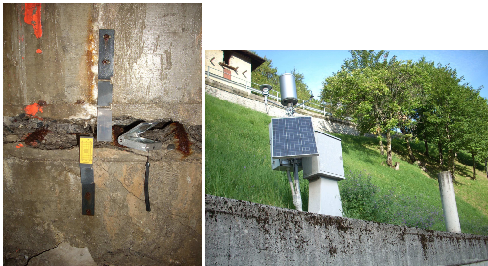
Fig. 4-6 :Elementi del monitoraggio posti dal Servizio Geologico. (a) estensimetri presso la vecchia galleria drenante vicino al Municipio; (b) Stazione di monitoraggio continuo e pilastrino per le misure GPS.
