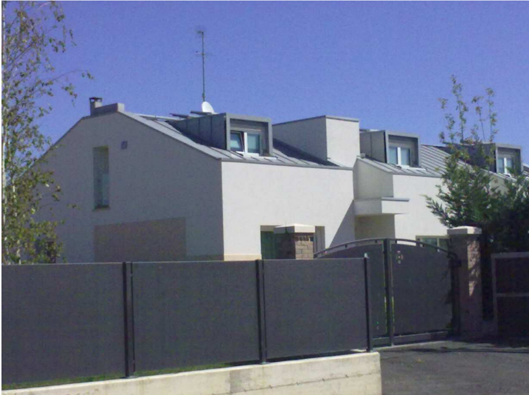
Fig. 30: Fabbricato a Rio, fraz. Ponte San Nicolò con canale di gronda incassato
