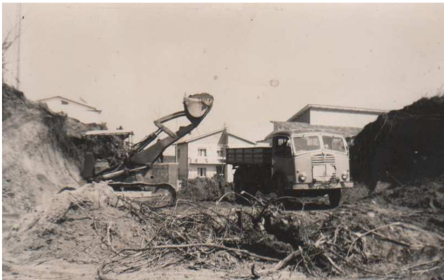
Fig. 6: Demolizione del ponte nella "strada nuova"
