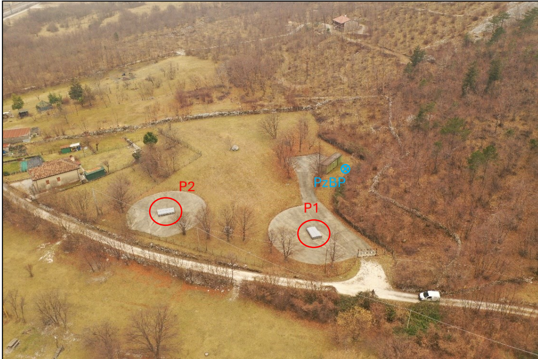
Figura 3-13: Il campo pozzi di Borgo Piccin: vista aerea da drone; in rosso i pozzi con il codice di riferimento; in azzurro il piezometro PzBP (foto: Nuova AGEPI).
