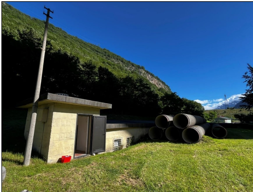
Figura 3-6: L'opera di captazione denominata Galleria Fitrante Negrisiola.
