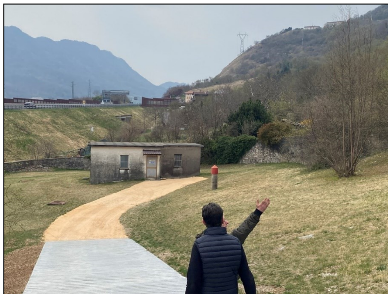
Figura 3-3: L'opera di captazione presso Forcal.
