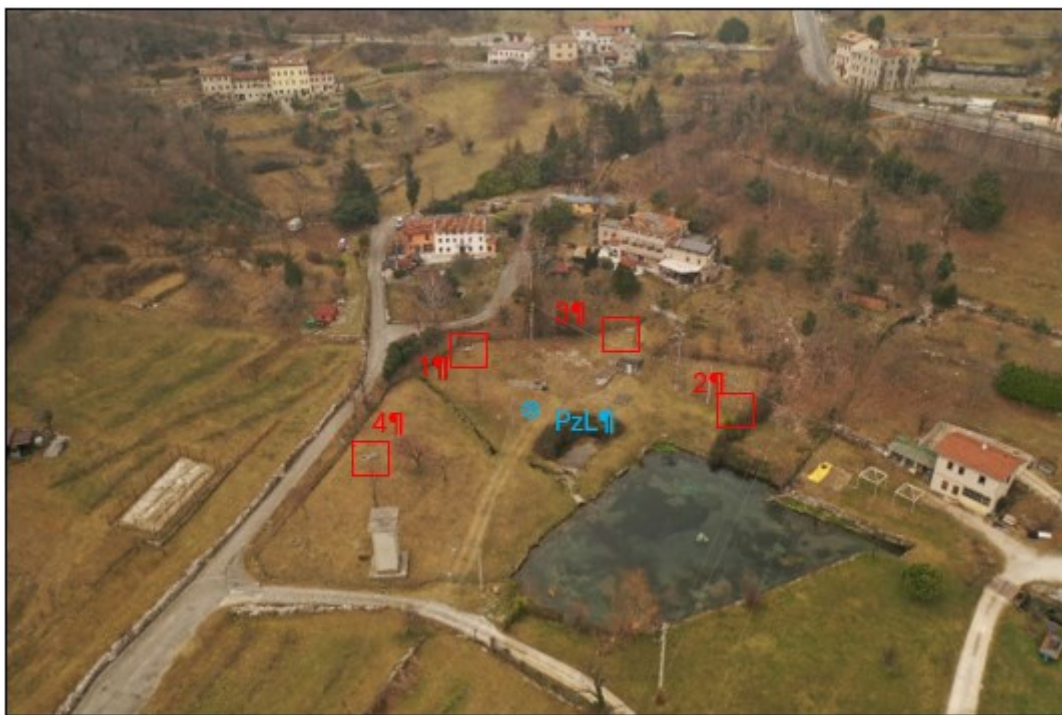
Figura 3-9: Il campo pozzi di Lagusel ripreso da drone: in rosso l'ubicazione dei pozzi con il numero di riferimento; in azzurro l'ubicazione di PzL (foto: Nuova AGEPI).
