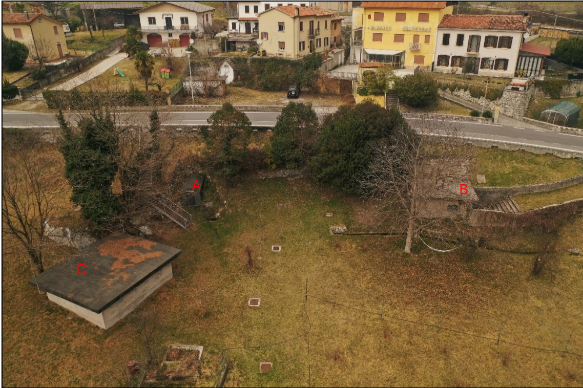
Figura 3-16: A: galleria drenante Belvedere; B: Sorgente San Floriano; C: serbatoio/vasca (foto Nuova AGEPI).
