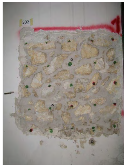
Figura 3.6. 43 - Campo prova 2 lato martello
