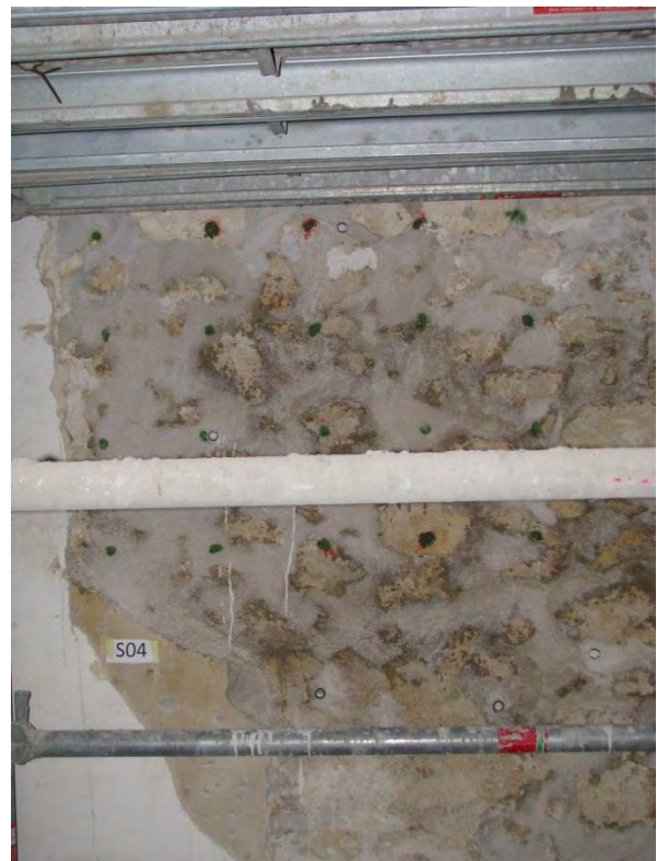
Figura 3.6. 54 - Campo prova 4 lato martello
