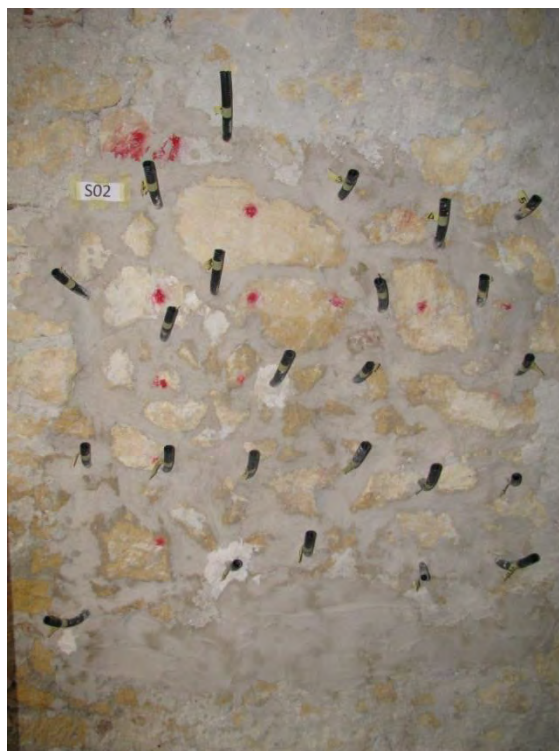
Figura 2.1.1 - Pannello pronto per l'iniezione (museo Archeologico di Verona)
