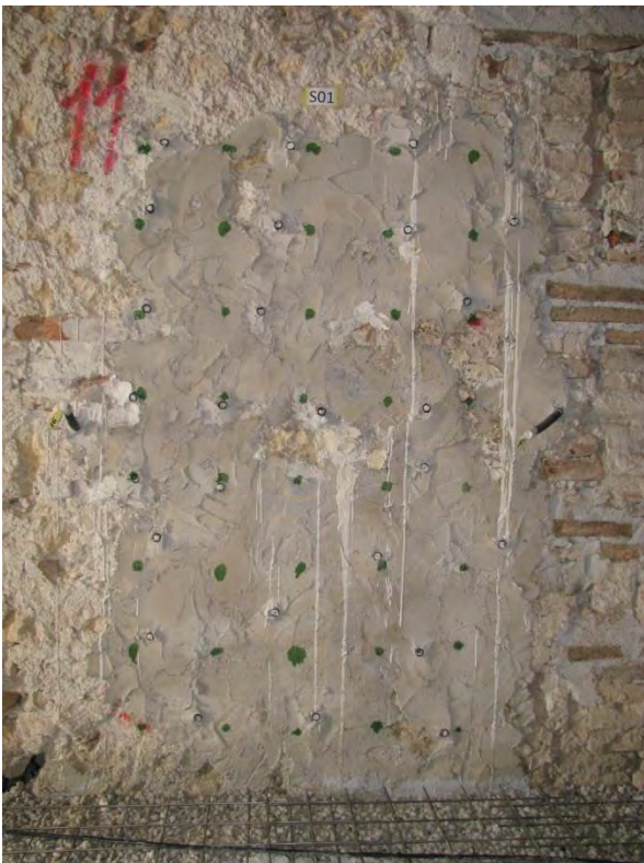
Figura 3.6. 37 - Campo prova lato martello
