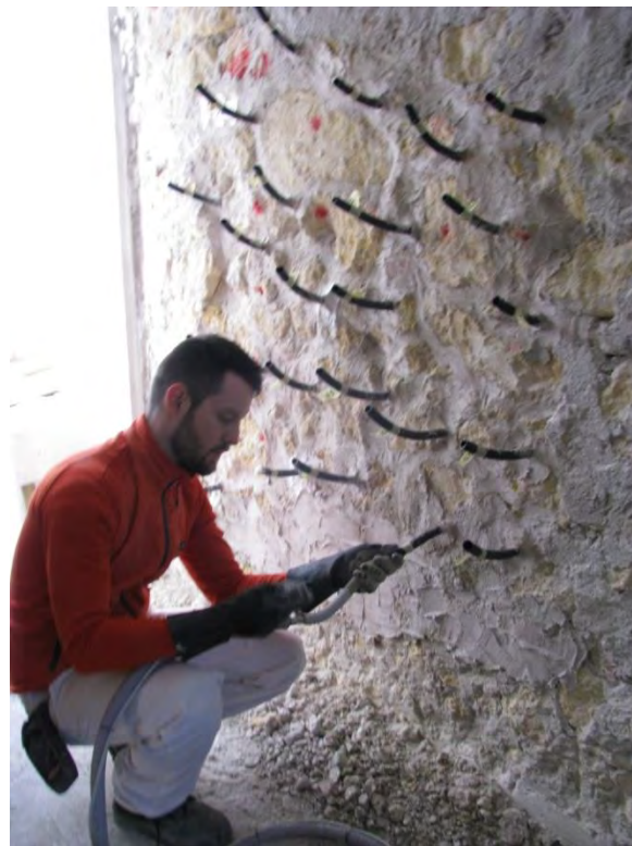
Fig. 1.2. 1 - Esecuzione dell'intervento di iniezione (Museo Archeologico di Verona)
