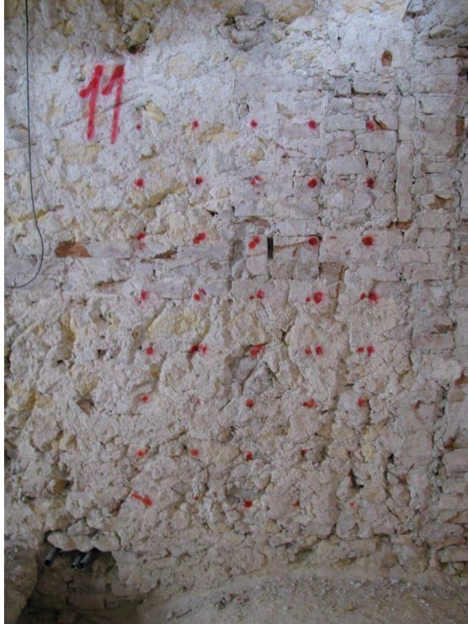
Figura 3.6. 11 - foto prospetto So1
