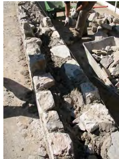
Figura 2.2. 2 - schema geometrico realizzazione muro a tre paramenti
