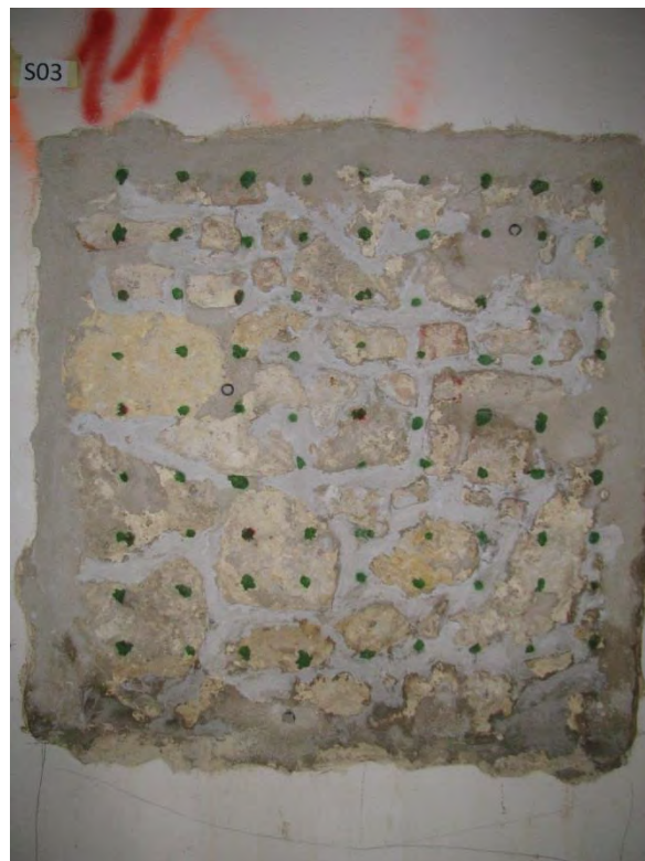
Figura 3.6. 49 - Campo prova 3 lato martello
