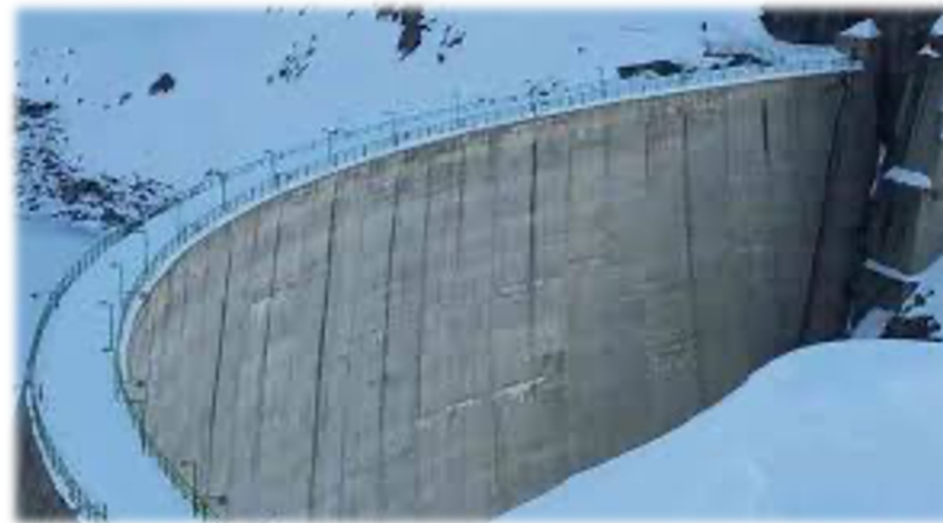
Diga del Chiotas - Piemonte
