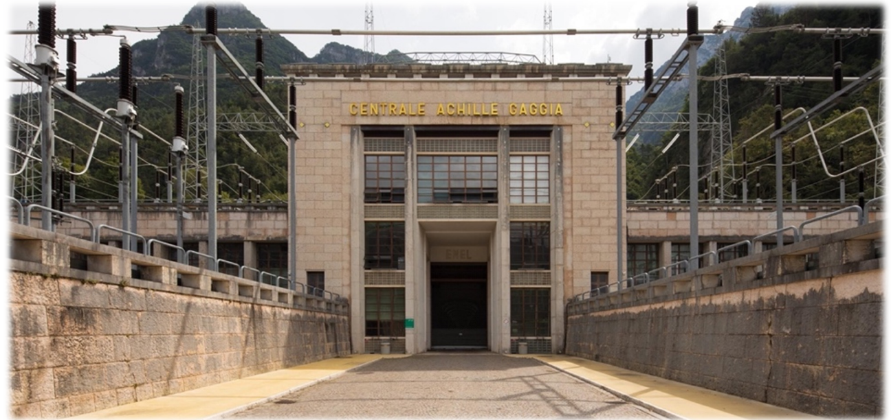
Centrale Achille Gaggia di Soverzene - Veneto
