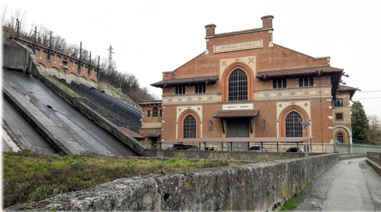
Centrale idroelettrica «Esterle»
