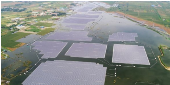
Impianto galleggiante in Cina.
