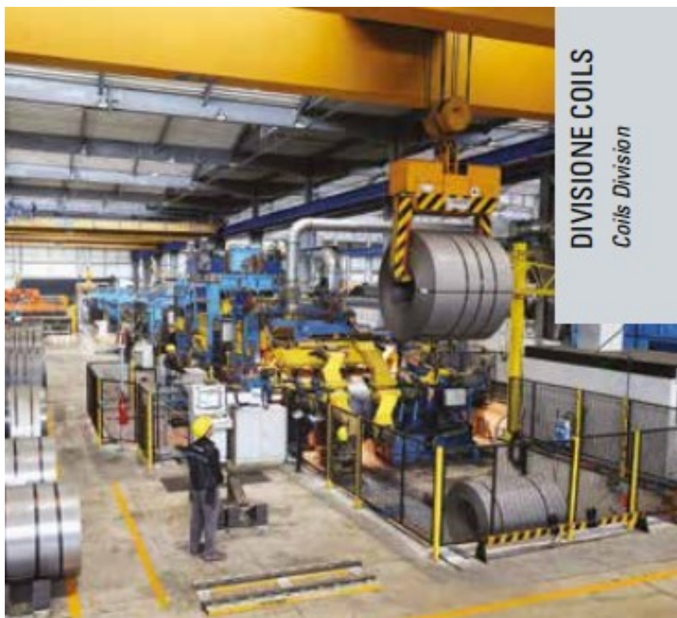
Figura 3.2 - Stabilimento di Via Mazzini a Cittadella (DCO) 38
