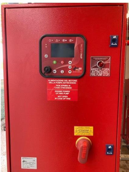
Il motore si avvia aprire del tutto la valvola. Il limite è a 72 m<sup>3</sup> e 7 atmosfere. Finito il test si richiude valvola e si spegne, resettando dal quadro elettrico.
