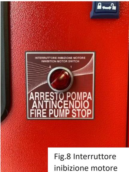
Fig.8 Interruttore inibizione motore
