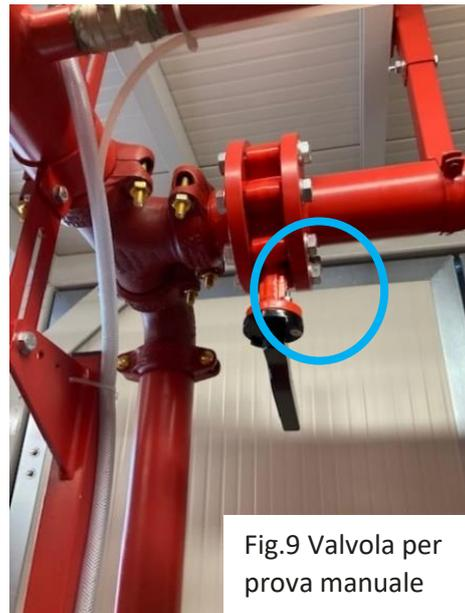
Fig.9 Valvola per prova manuale
