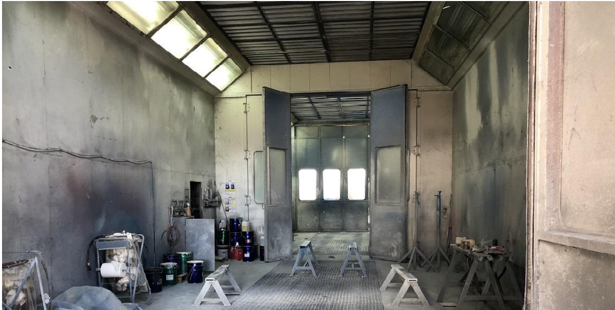
Figura 1. 19: Vista dell'interno della cabina di verniciatura per componenti ingombranti
