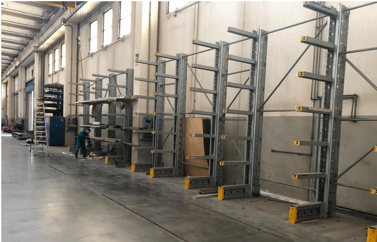
Figura 4. 8: Foto delle operazioni di sgombero dei cantilever dai materiali presenti
