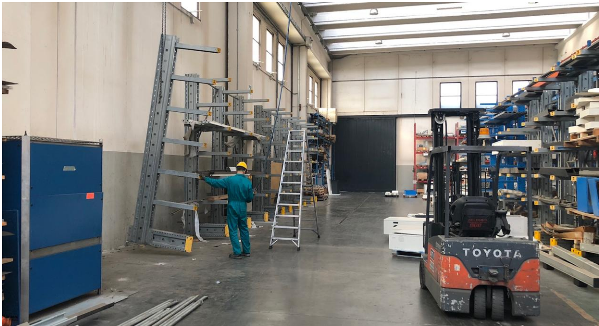
Figura 4. 9: Immagine delle fasi di smontaggio dei vari cantilever
