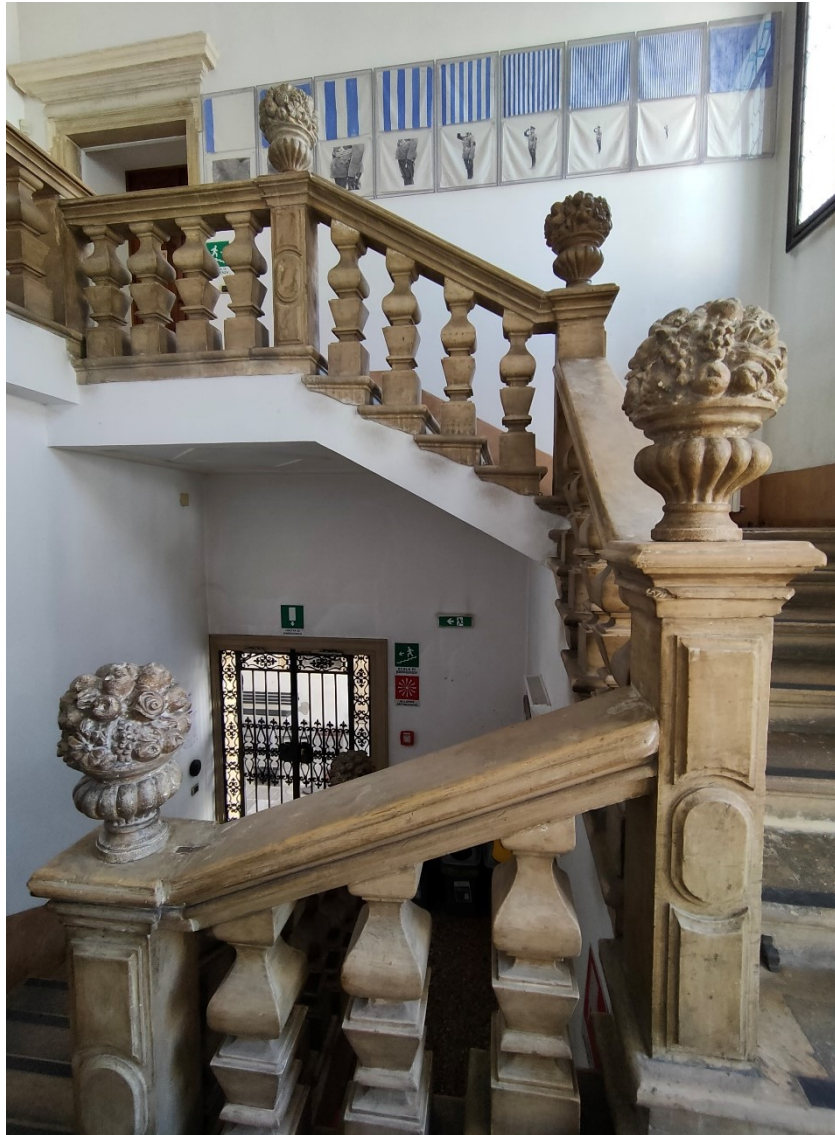
Fig. 101 – Palazzo Selvatico, Padova, via Vescovado. Dettaglio della balastra dello scalone.
