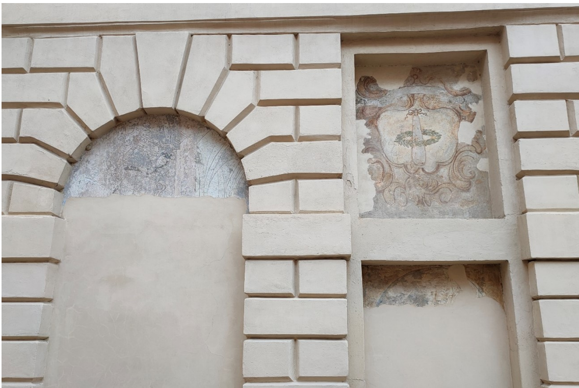
Fig. 95 – Palazzo Selvatico, Padova, via Vescovado. Dettaglio del prospetto meridionale della palazzina «dietro Duomo».
