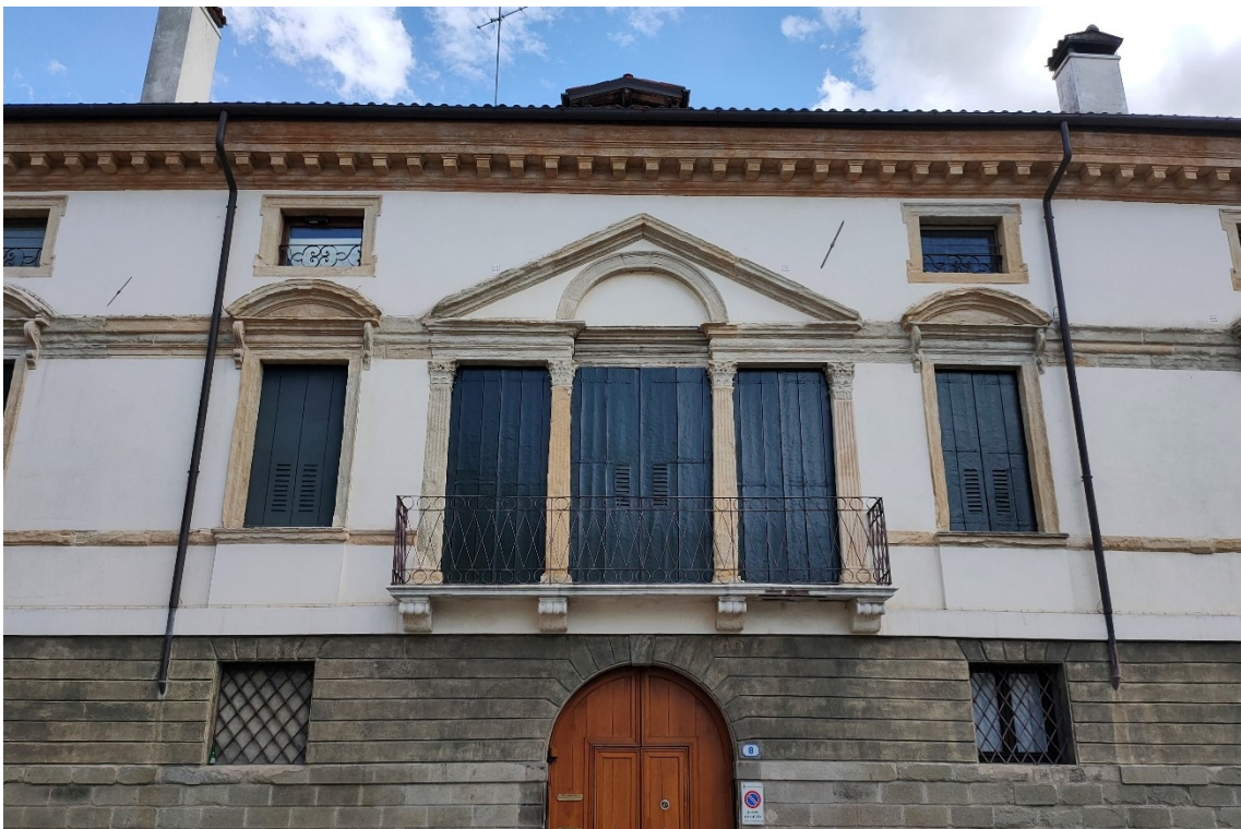
Fig. 57 – Palazzo Marcato-Belloni, dal 1457, Padova, via Rudena. Dettaglio della facciata principale.
