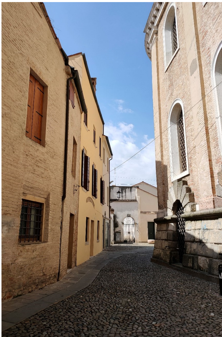
Fig. 32 – Via Dietro Duomo tra la sacrestia meridionale della Cattedrale e quel che rimane della casa canonica di Petrarca con, sullo sfondo, uno degli accessi al Palazzo Selvatico. Vista verso Ovest.
