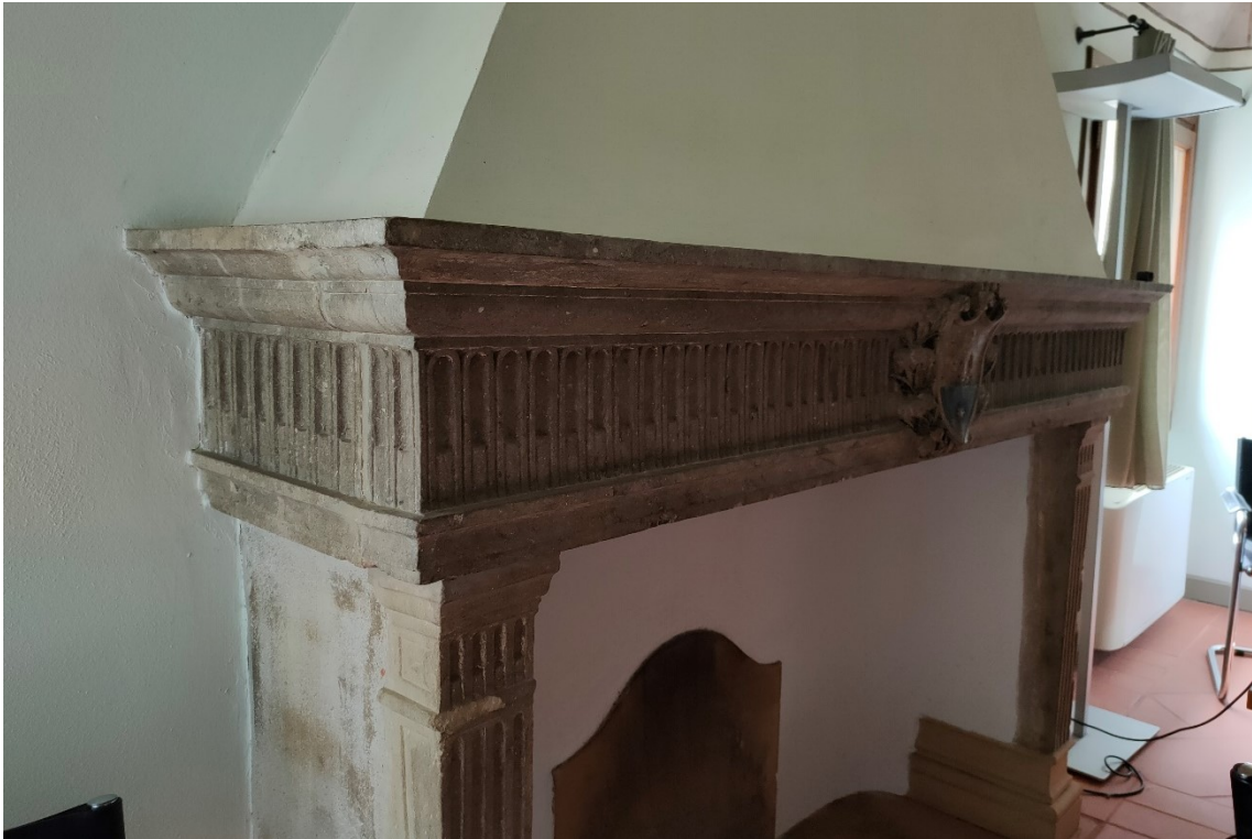
Fig. 90 – Palazzo Selvatico, Padova, via Vescovado. Dettaglio del camino al secondo piano della palazzina «dietro Duomo».
