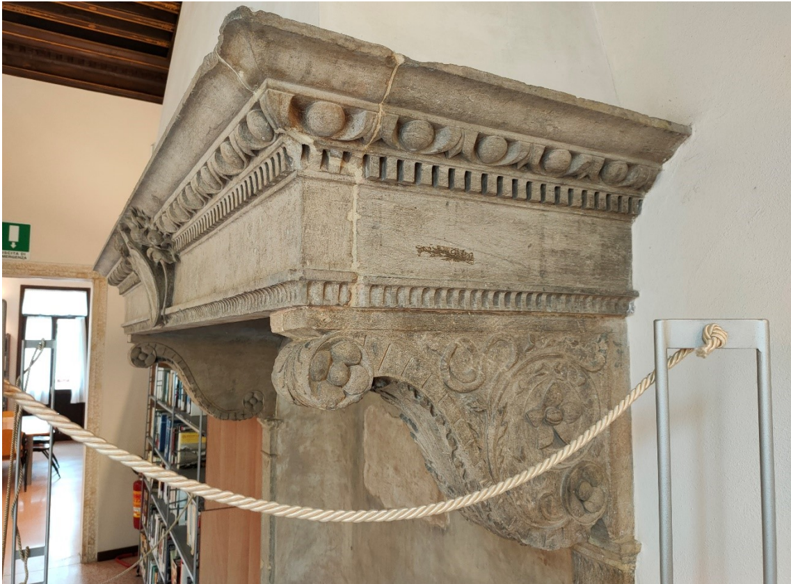
Fig. 88 – Palazzo Selvatico, Padova, via Vescovado. Dettaglio di uno dei camini al piano nobile.
