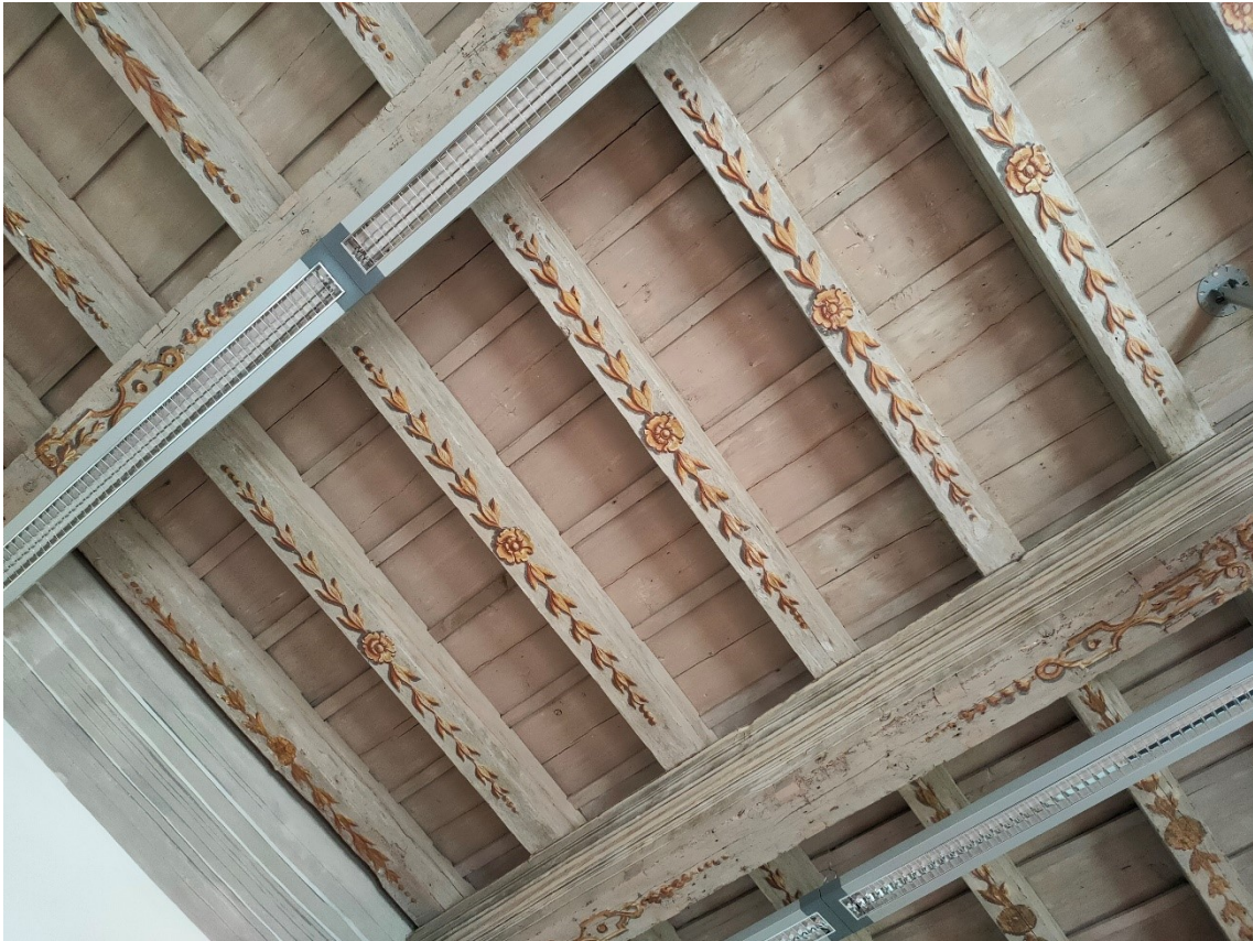
Fig. 100 – Palazzo Selvatico, Padova, via Vescovado. Dettaglio del soffitto alla sansovina di una stanza al piano terra dell'ala occidentale del palazzo.
