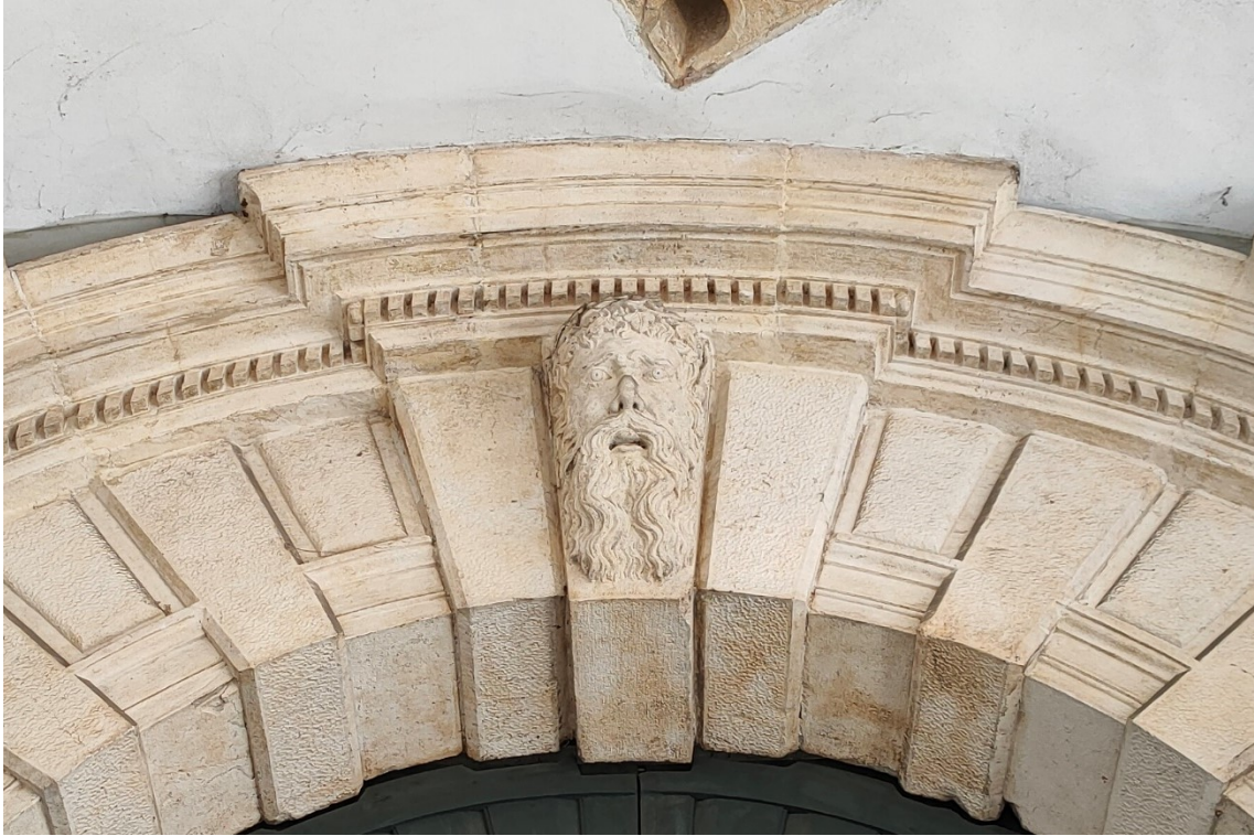
Fig. 70 – Palazzo Selvatico, Padova, via Vescovado. Dettaglio della chiave di volta con mascherone.
