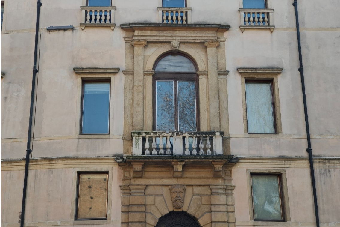
Fig. 73 – Palazzo Foscari, Padova, via degli Eremitani. Dettaglio della facciata settentrionale con la chiave di volta con mascherone.
