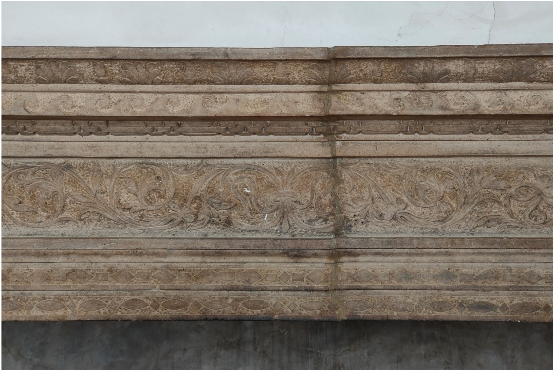
Fig. 85 – Palazzo Selvatico, Padova, via Vescovado. Dettaglio di uno dei camini al piano nobile.
