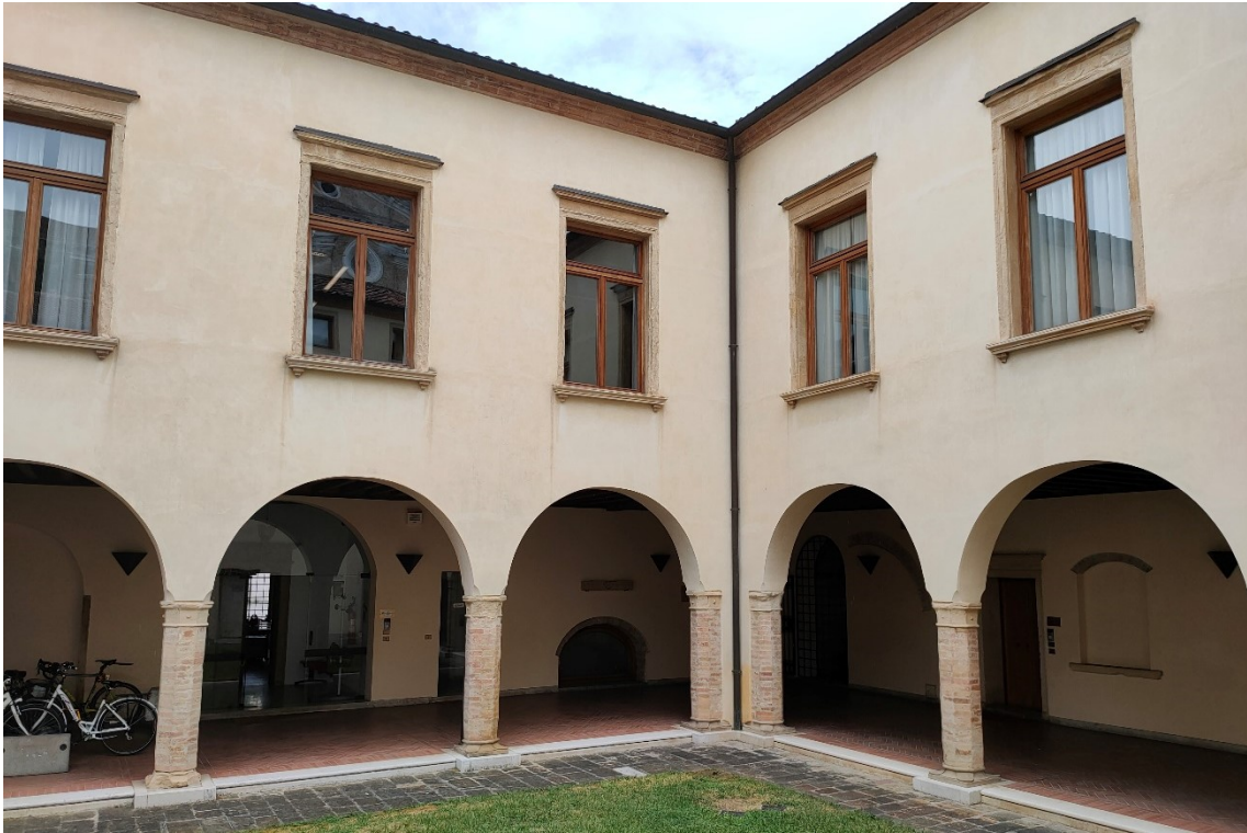
Fig. 34 – Portico a L del cortile della casa dell'arciprete, Padova, via Dietro Duomo. Vista da una finestra del lato occidentale del blocco settecentesco del Palazzo Selvatico.
