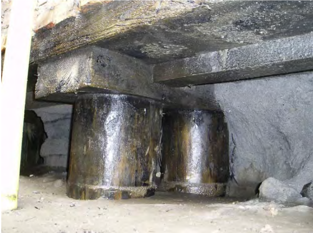
Figura 2.4 : Tipica fondazione a pali accoppiati di Amsterdam (Klassen et al., 2012)
