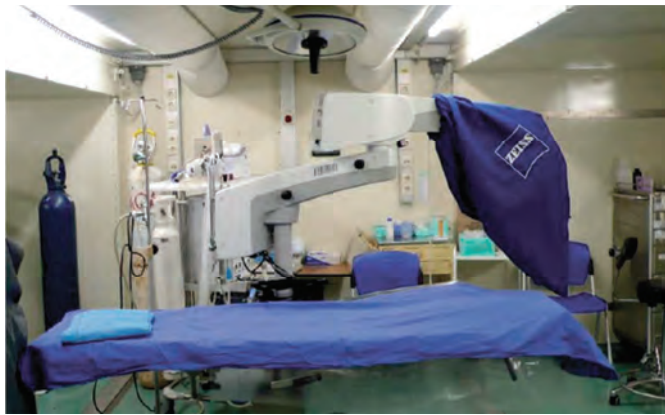
Figura 4.3.1. – 02 : Sala operatoria allestita in modulo 3V di MMH.
