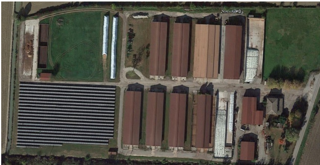
Figura 18. Immagine aerea della disposizione dell'allevamento presente in provincia di Rovigo (fonte: Google Earth)
