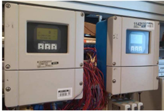
Fig. 12 Trasduttori di portata
