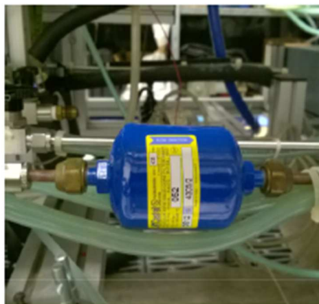
Fig. 4 Filtro disidratatore
