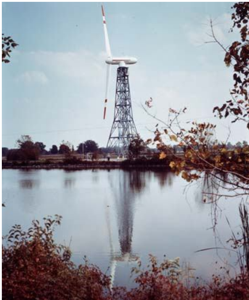
Figura 2.3 Turbina MOD-0
