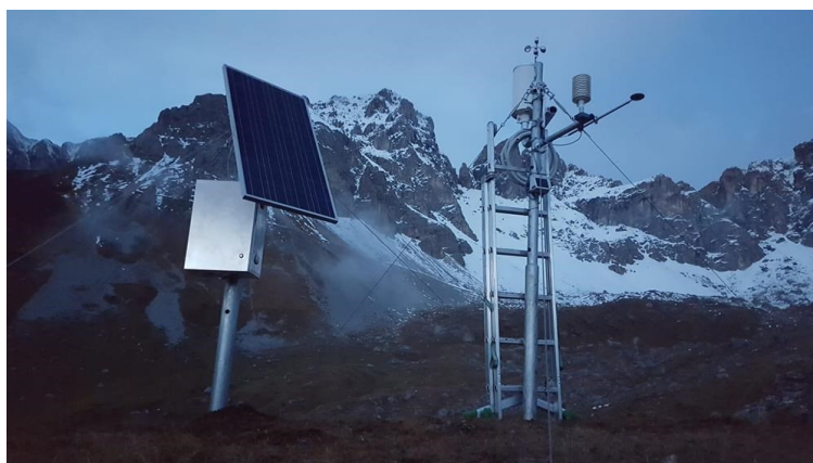
Figura 13: stazione meteo di monte
