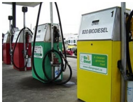
Figura 11. Stazione di servizio predisposta d'erogatore miscela B20
