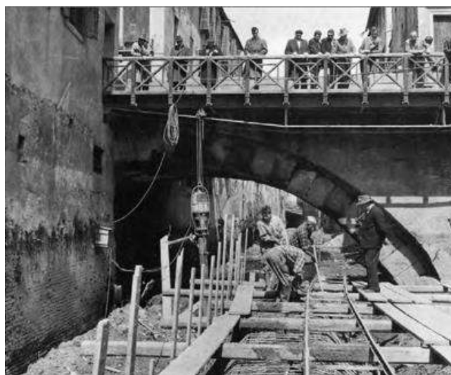
Fig. 2.20: Riviera dei Ponti Romani: operazioni di tombinamento del Naviglio interno che ha determinato l'obliterazione del Ponte Altinate nel 1956-1957. (MOZZI, 2021, p.17. Fig. 9).
