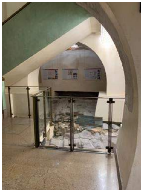
Fig. 2.11: Veduta del pianerottolo. (Foto: Letizia Favaro).
