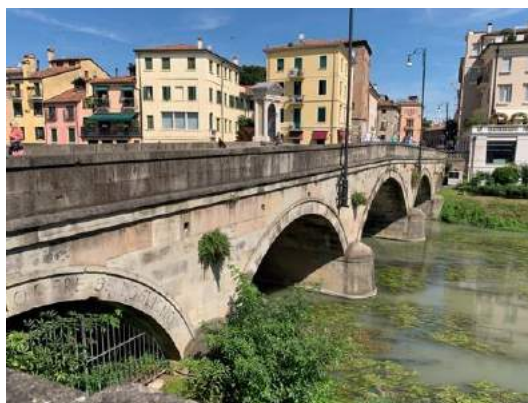
Fig. 2.4: Veduta orientale del Ponte Molino. (Foto: Letizia Favaro).
