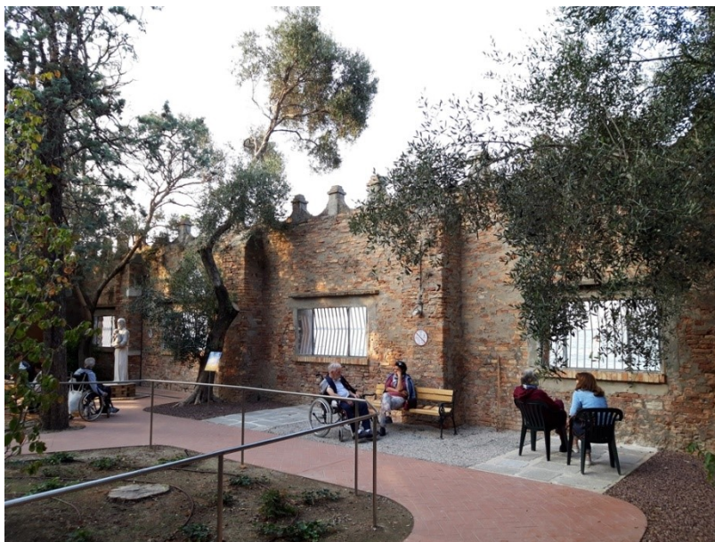
Figura 12 – La ristrutturazione conclusa delle "finestre sul mare" – Giorno dell'inaugurazione (Progetto Daniele Conte architetto paesaggista | Progetto di healing garden per l'Ospedale Fatebenefratelli di Venezia – 2017)
